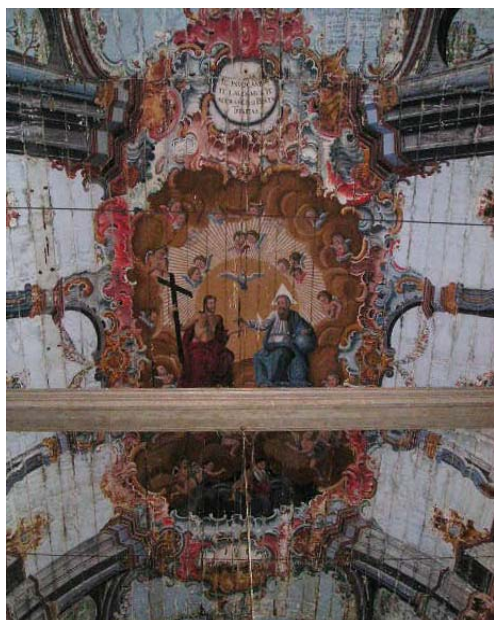
Figura 398 – Pintura de la bóveda de la nave de la Igreja do Senhor Bom Jesus de Matosinhos, en Santo Antonio de Pirapetinga.
