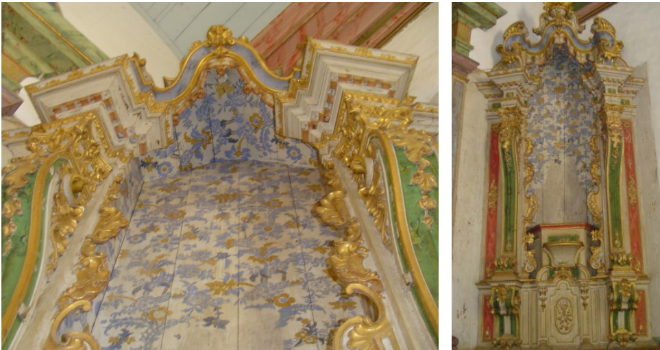
Figura 625 – Pintura del tapizado del camarín.
