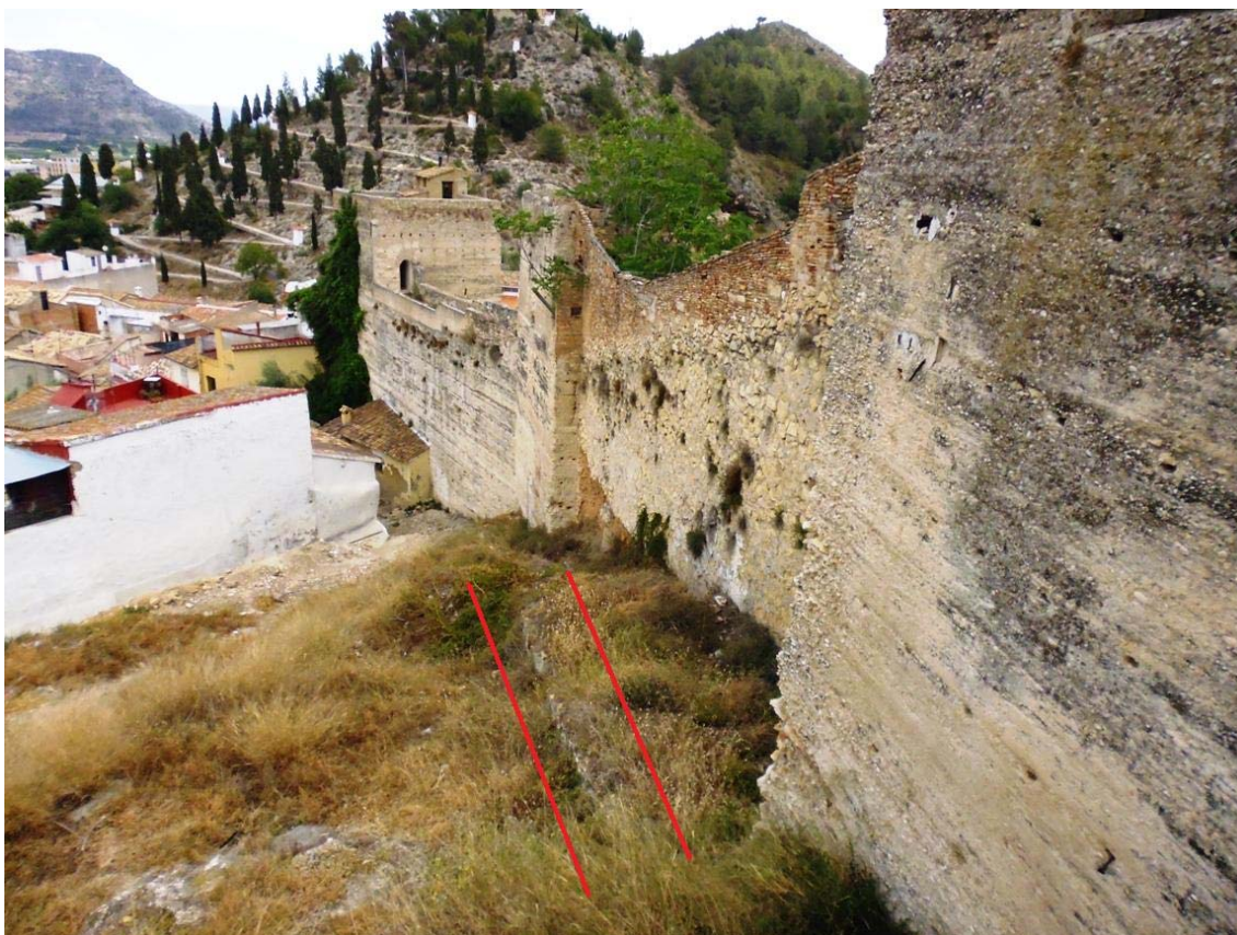
-Posible muro del antemural de la muralla de Xàtiva (Foto Ferrandis 2014).
