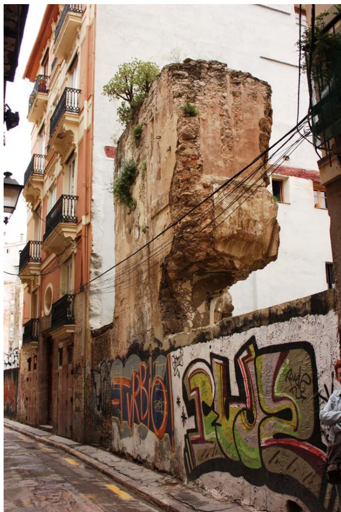
-Imagen del muro existente en la calle Salinas (Foto Ferrandis 2009).
