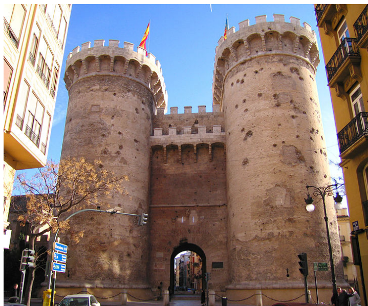
-Imagen general del Portal de Quart , visto desde el exterior –de la antigua muralla- (Ferrandis 2009).
