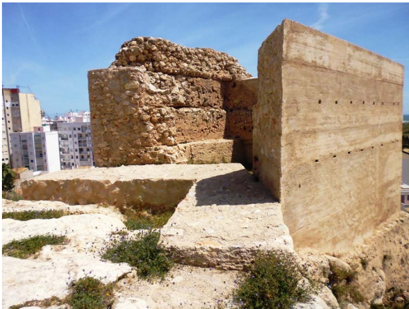
-Torre Miranda, donde se aprecia muy bien su técnica constructiva a base de tapia de mortero de cal con piedras en su núcleo (Foto Ferrandis 2014).
