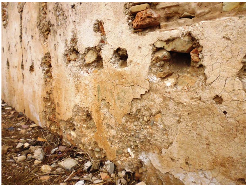
-Lienzo Sur de la muralla sin restaurar donde se observa el mortero de cal del muro (Foto Ferrandis 2014).
