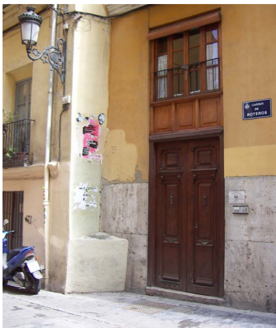
-Cambio de alineación motivado por la existencia de la línea de muralla (Foto Ferrandis 2010).
