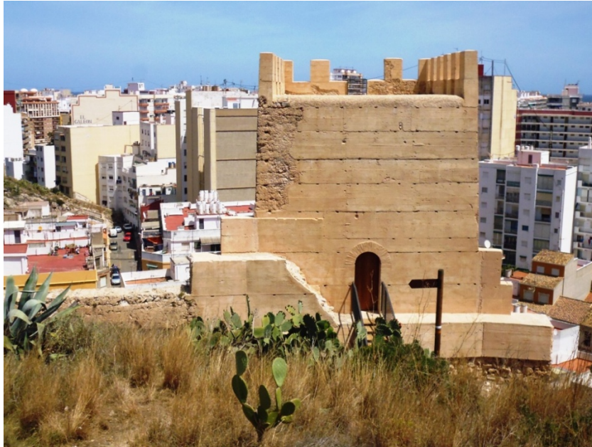
-Imagen de la Torre del Racó, tras su restauración (Foto Ferrandis 2014).
