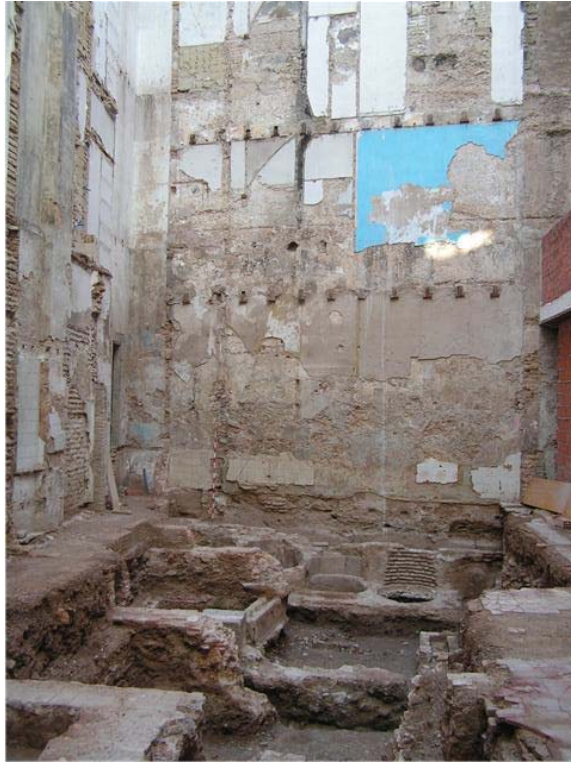
-Imagen general de la intervención. En el fondo, muro medianero/muralla islámica (Archivo SIAM).
