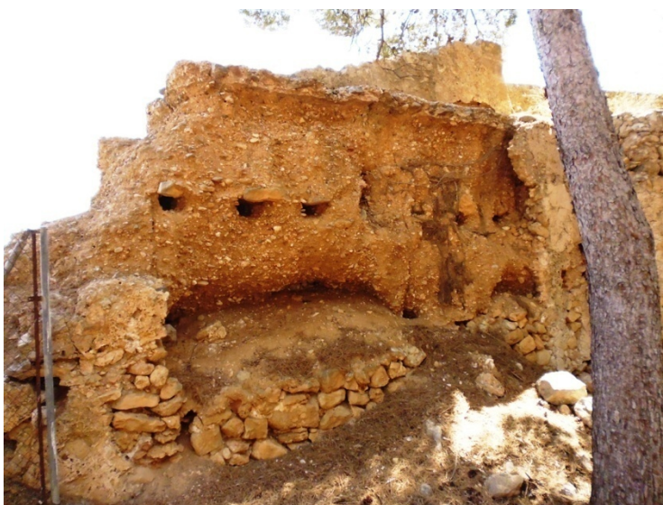
-Muros de tapia de tierra con la costra perdida (Foto Ferrandis 2014).
