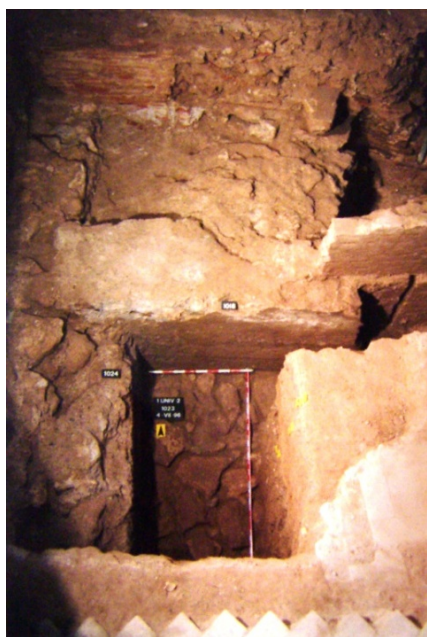
-Imagen general de la intervención con la muralla y torre (Archivo SIAM).
