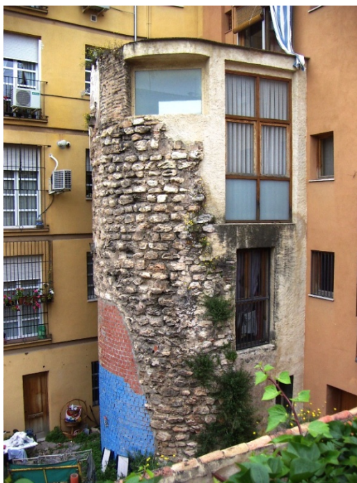
-La torre tras la intervención arquitectónica (Foto Ferrandis 2009).
