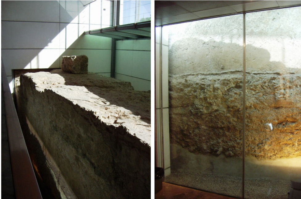
-Imágenes de la muralla con su fábrica de tapia de tierra y cimentación de argamasa (Fotos Ferrandis 2009).
