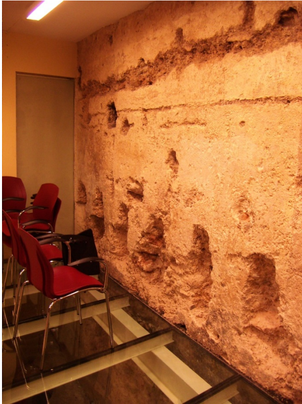
-Detalle de la integración de la nueva edificación con respecto a la muralla (Ferrandis 2009).
