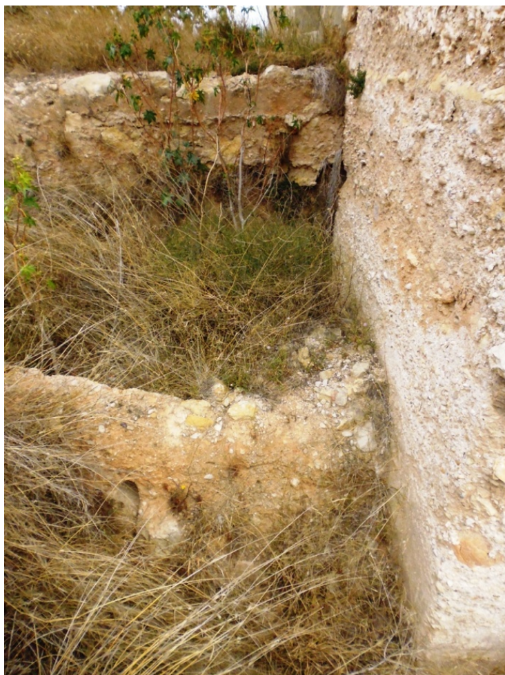
-Posible muro del antemural de la muralla de Xàtiva (Foto Ferrandis 2014).
