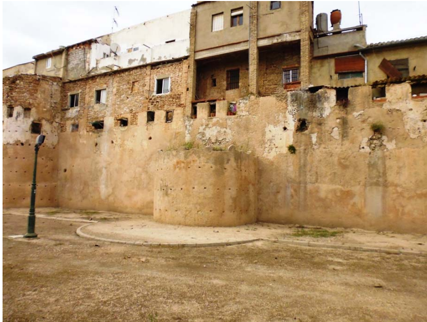
-Torre desmochada de la muralla de Alzira, en la zona Sur (Foto Ferrandis 2014).
