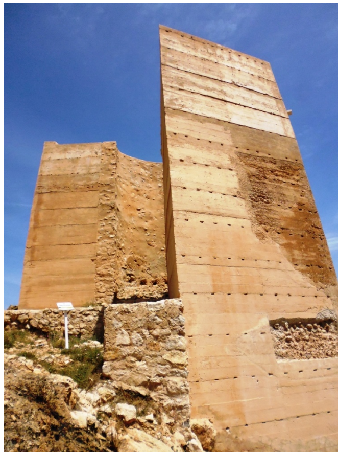
-Torre Octogonal, detalles constructivos (Foto Ferrandis 2014).
