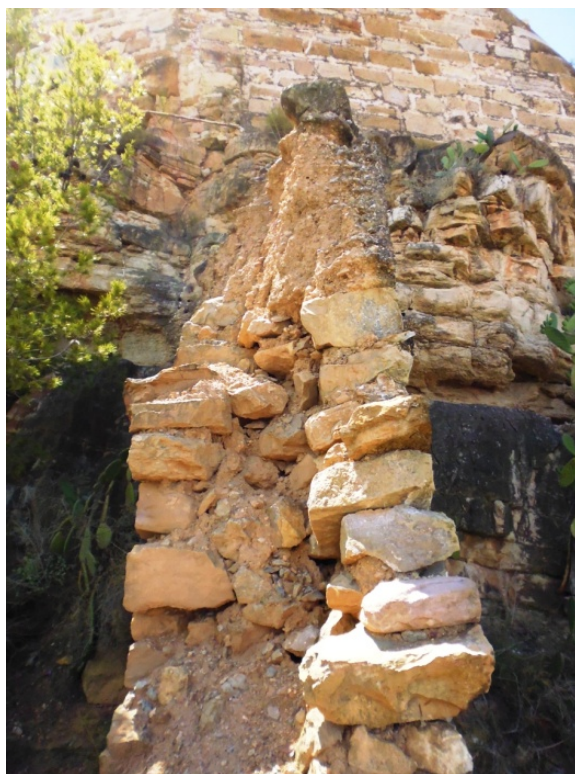
-Sobre base de mampostería, muro de tapia (Foto Ferrandis 2014).
