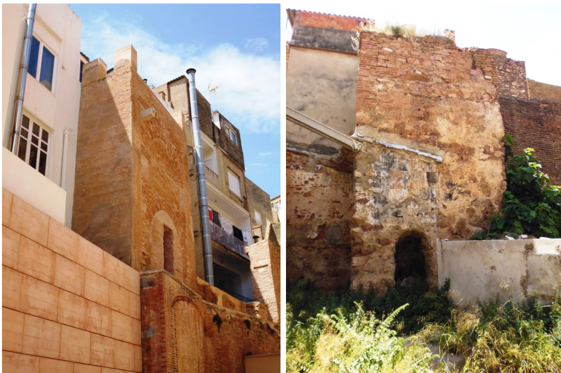
-Imágenes de sendas torres de la muralla de Burriana (Fotos Ferrandis 2013).
