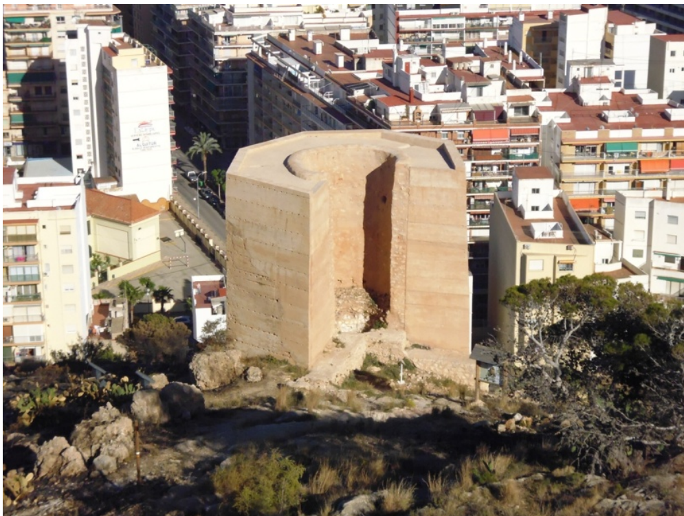
-Imagen de la Torre Octogonal, tras su restauración (Foto Ferrandis 2014).
