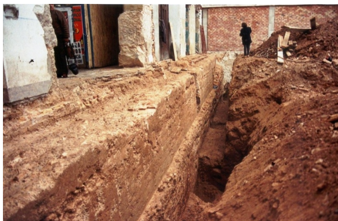
-Imagen del muro y cimentación de la muralla (Foto Taberner 1996).
