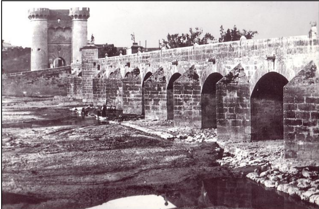
-Foto del Portal Nou y puente de San José.
