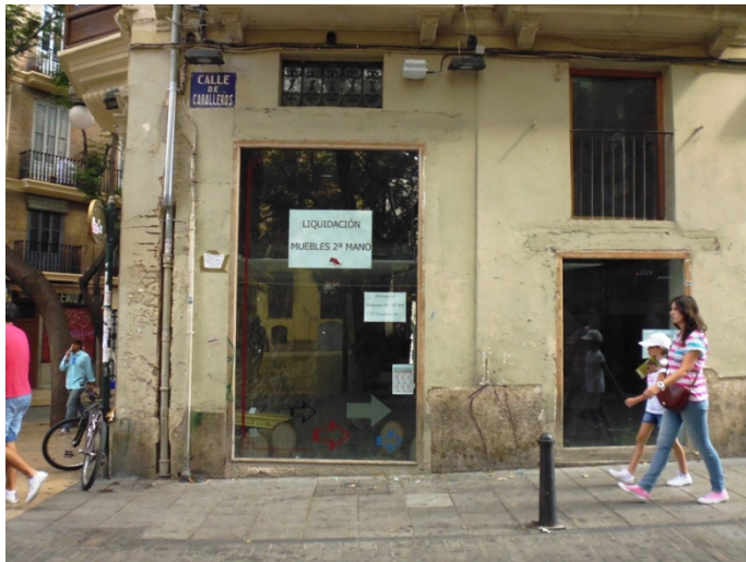
-Exterior del inmueble donde se hallan los restos murales (Ferrandis 2015).
