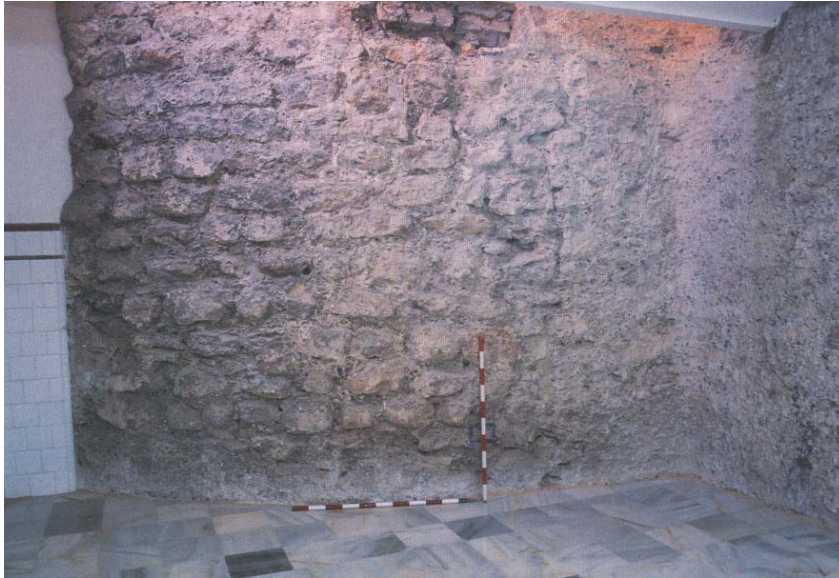
-Alzado de la torre tras eliminación de revocos impropios (Archivo SIAM).
