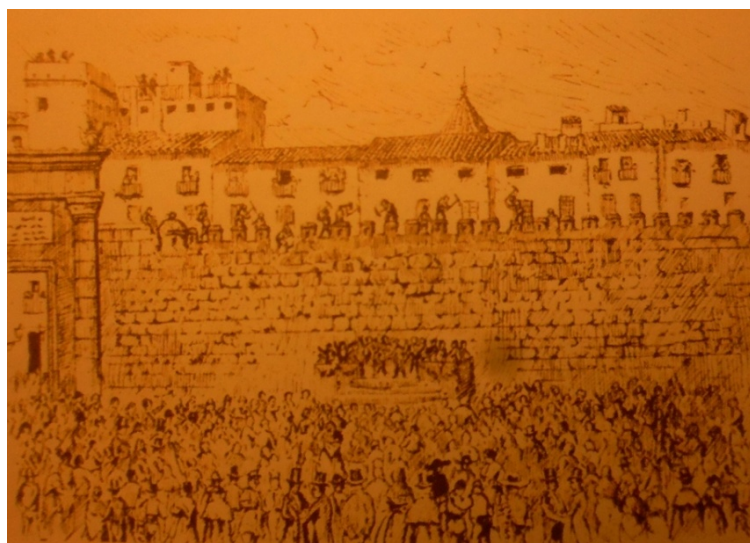
-Grabado del inicio del derribo (Aldana, 2006).
