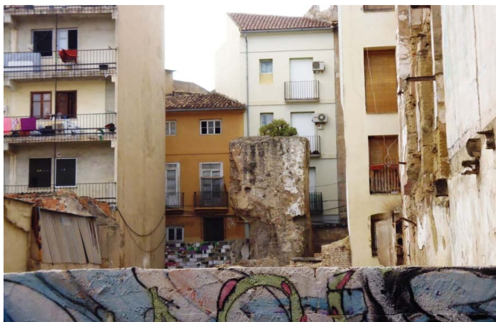
-Imagen del mismo muro (Ferrandis 2015).
