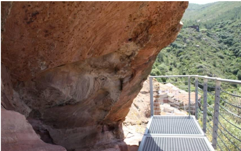
Figura 238. Aspecto actual del Abric del Castell de Vilañamés (Castellón), con la instalación de la pasarela metálica, para facilitar el acceso sin necesidad de pisar la superficie de la roca.
