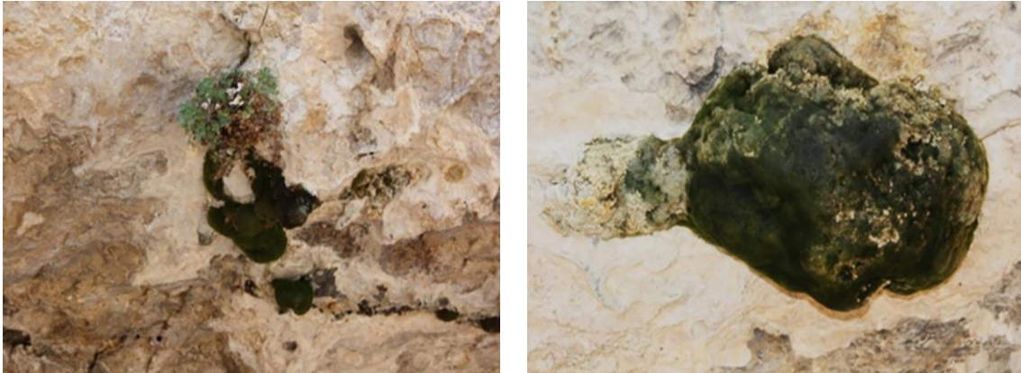
Figura 137-138. Alteración biológica de la superficie pétreo de Cova Remígia. Presencia de plantas superiores e inferiores (musgo).
