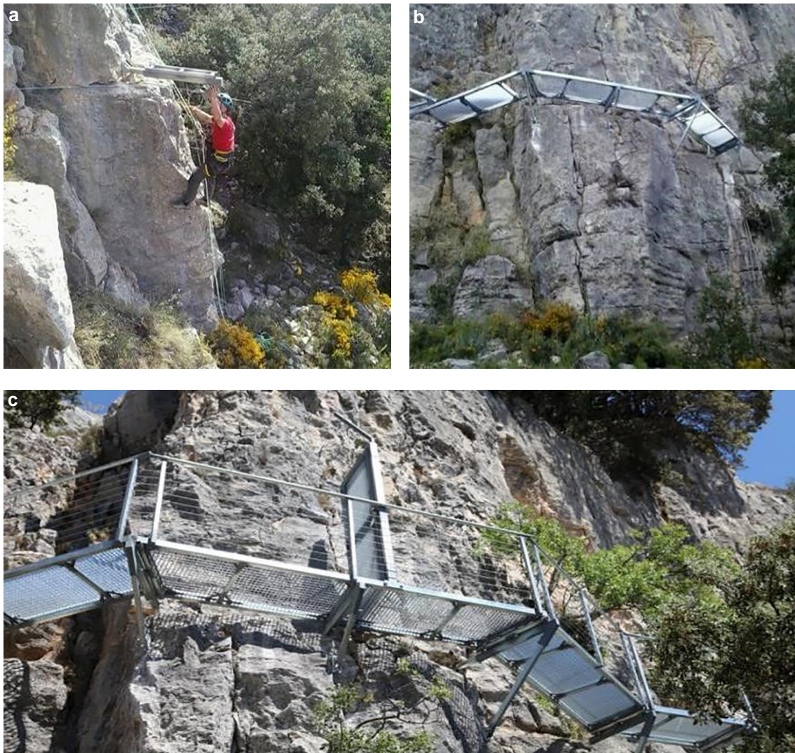
Figura 61 (a, b, c). Montaje de la pasarela entre Cova Remígia y el Cingle de Mola Remígia . (Barranc de Gassulla-Ares del Maestre).
