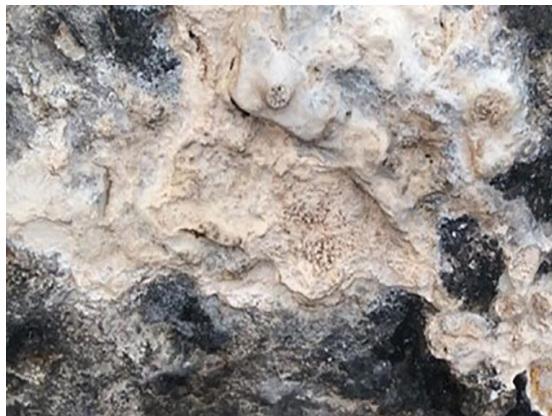
Figura 142. Bioalteración de la superficie pétrea de Cova Remígia y presencia de costras de carbonato cálcico.
