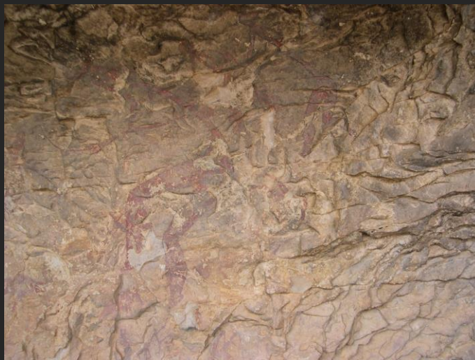
Perfilado, descamación y pérdida de soporte y película pictórica, (cavidad n° 5).
