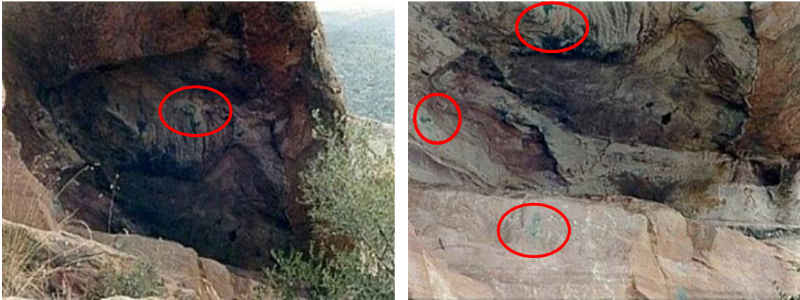
Figuras 235-236. Vista general del Abric del Castell de Villafamés (Castellón), antes de la intervención de conservación. Las zonas señaladas muestran los grafiti realizados con spray verde, agresión antrópica sufrida en 1998.
