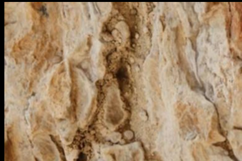
Disolución del soporte por acción de la colada.
