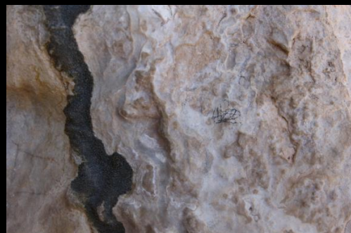
Concreción calcárea y biopátina
