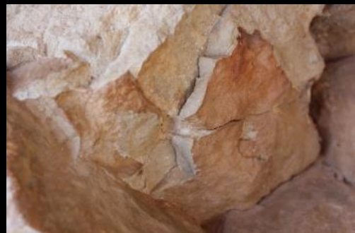
Fragmentación y desprendimiento.
