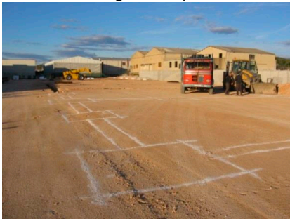
Figura 17. Replanteo del movimiento de tierras. Imagen: V. Yepes
