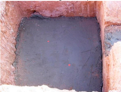
Figura 19. Hormigón de limpieza. Imagen: V. Yepes
