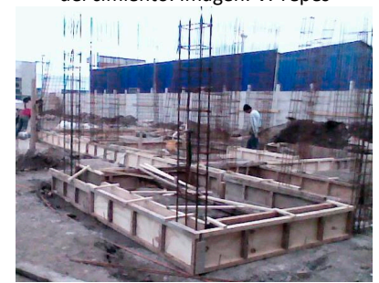
Figura 22. Encofrado de zapatas. Fuente: http://constructorinmobiliario.blogspot.com.es/
