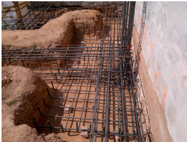
Figura 11. Zapata de medianería. Imagen de J. Martínez ( http://www.soloarquitectura.com/foros )
