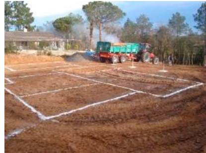
Figura 16. Marcado de la cimentación. Fuente: http://www.newjoquesa.net/
