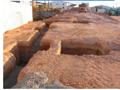
Figura 18. Excavación hasta la cota superior del cemento. Imagen: V. Yepes
