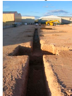
Figura 20. Excavación hasta la cota superior del cemento. Imagen: V. Yepes
