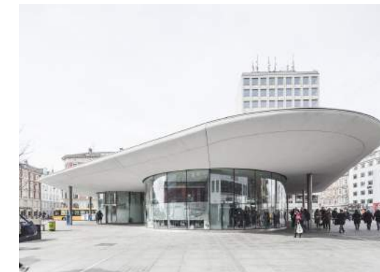
Figura 63-64. Comparativa real y virtual desde el exterior de las plataformas. Imagen virtual: COBE Architects, 2009. Imagen real: COBE Architects, 2015.
