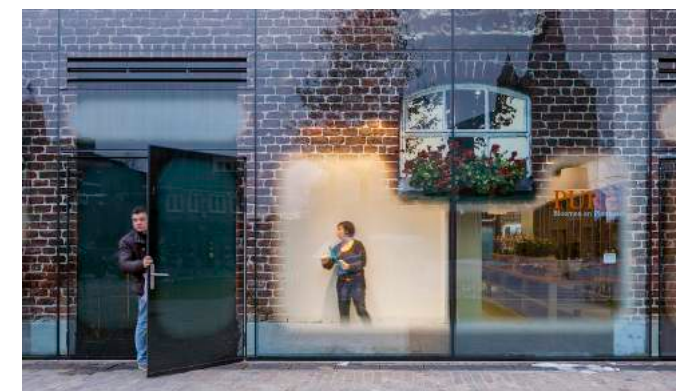
Figura 44. Detalle de fachada. MVRDV, 2013.
