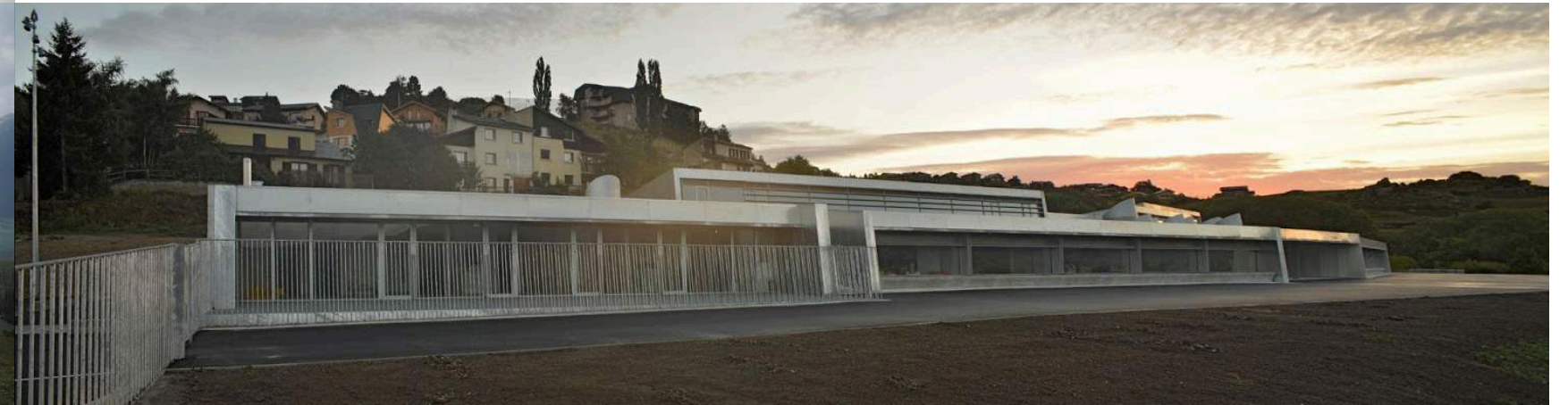
Figura 83. Imagen real. Grupo escolar Fon Romeu. Proyecto: RCR Architectes. Imagen: Vicent Parasié (2014).
