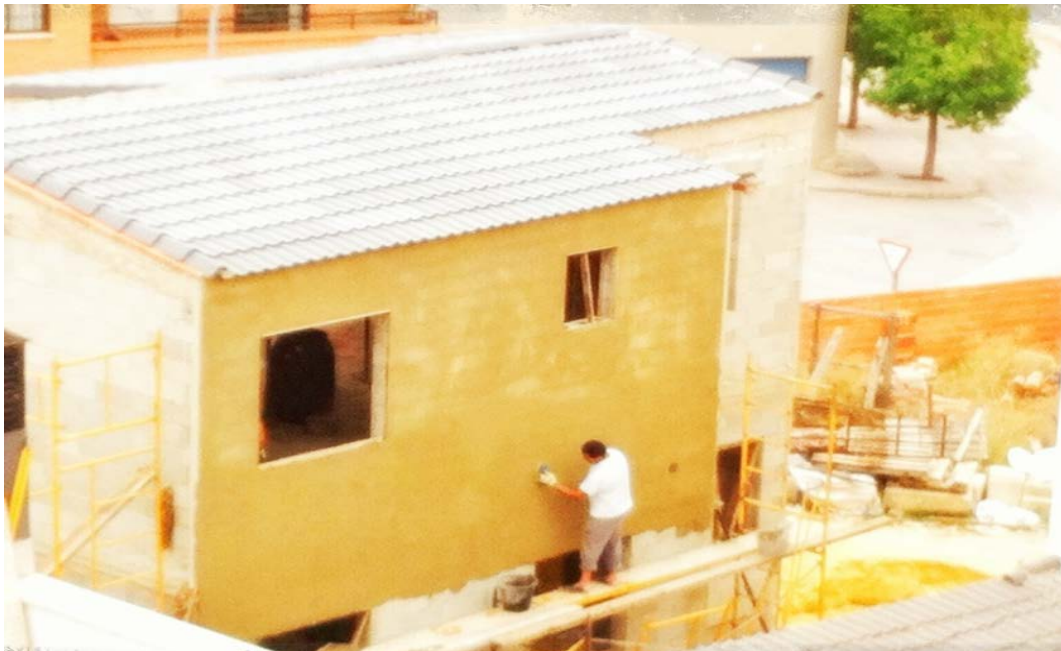
106. Manuela Navarro y Enrique Alegre, trabajo de campo: Imagen de constructor que le construye la casa a su hermana. 2015.
