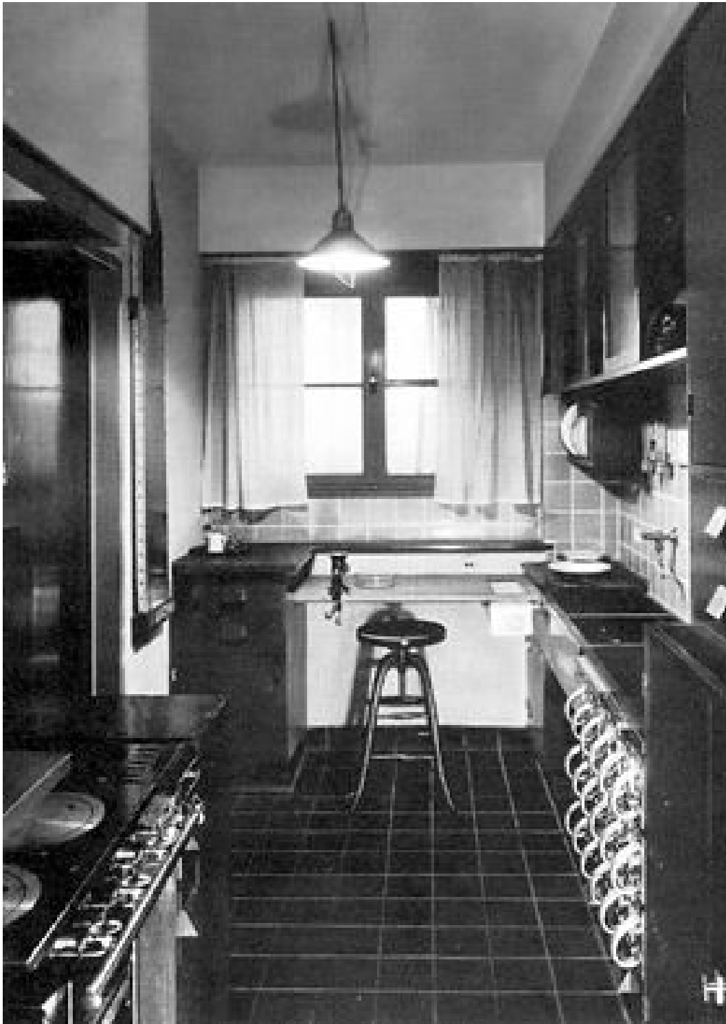
39. Margarete Schütte-Lihotzky, The Frankfurt kitchen (vista desde la entrada), 1926.
