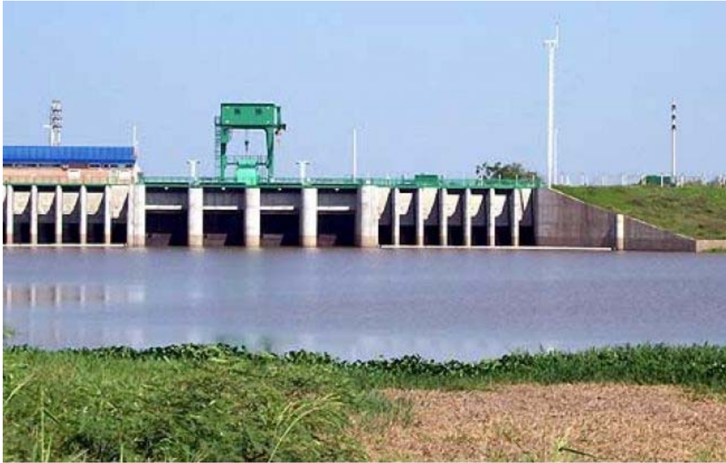
Figura 14. Obras de control del río Negro en su desembocadura en el río Paraná. Fuente: www.chacodiapordia.com Link: http://chacodiapordia.com/noticia/52748/la-apa-comenzo-a-descomprimir-el-rio-negro-y-cerro-compuertas-del-dique
