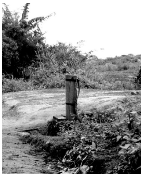
Figura 5. Grifo de uso público para la provisión residencial de agua en puntos de consumo que cuentan con red de distribución.
