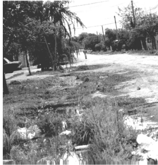
Figura 8. Zanjas a cielo abierto que reciben descargas de Aguas residuales tratadas “In situ” y desagües pluviales.
