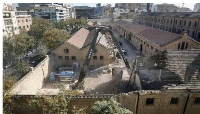
Derribo de naves, Valencia, 2007. [EFE/Juan Carlos Cárdenas]
