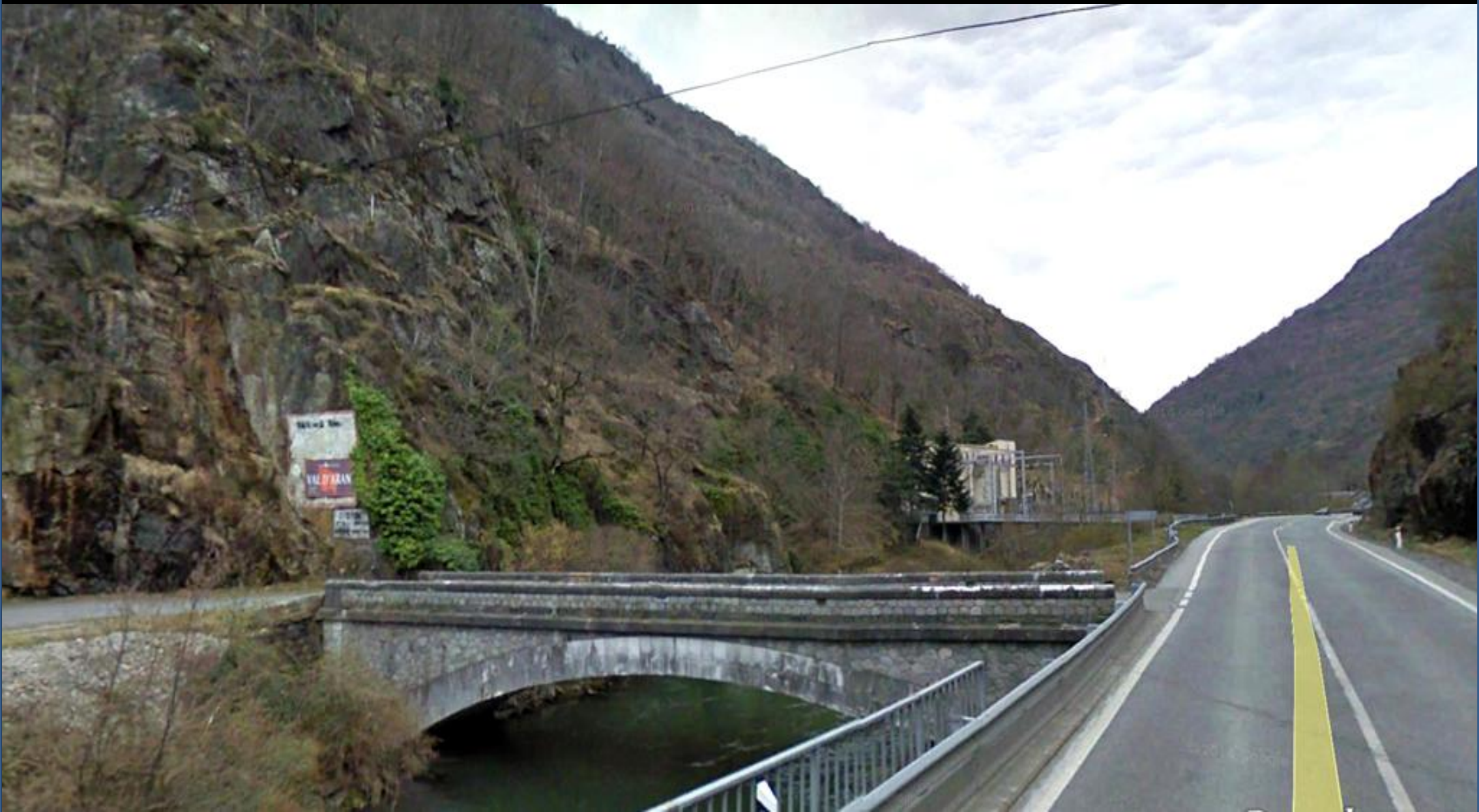
Puente sobre el río Garona. Pizarras, areniscas y cuarcitas del Cambro-Ordovícico. Valle de Arán, SE Hoja de Canejan, Lérida.
