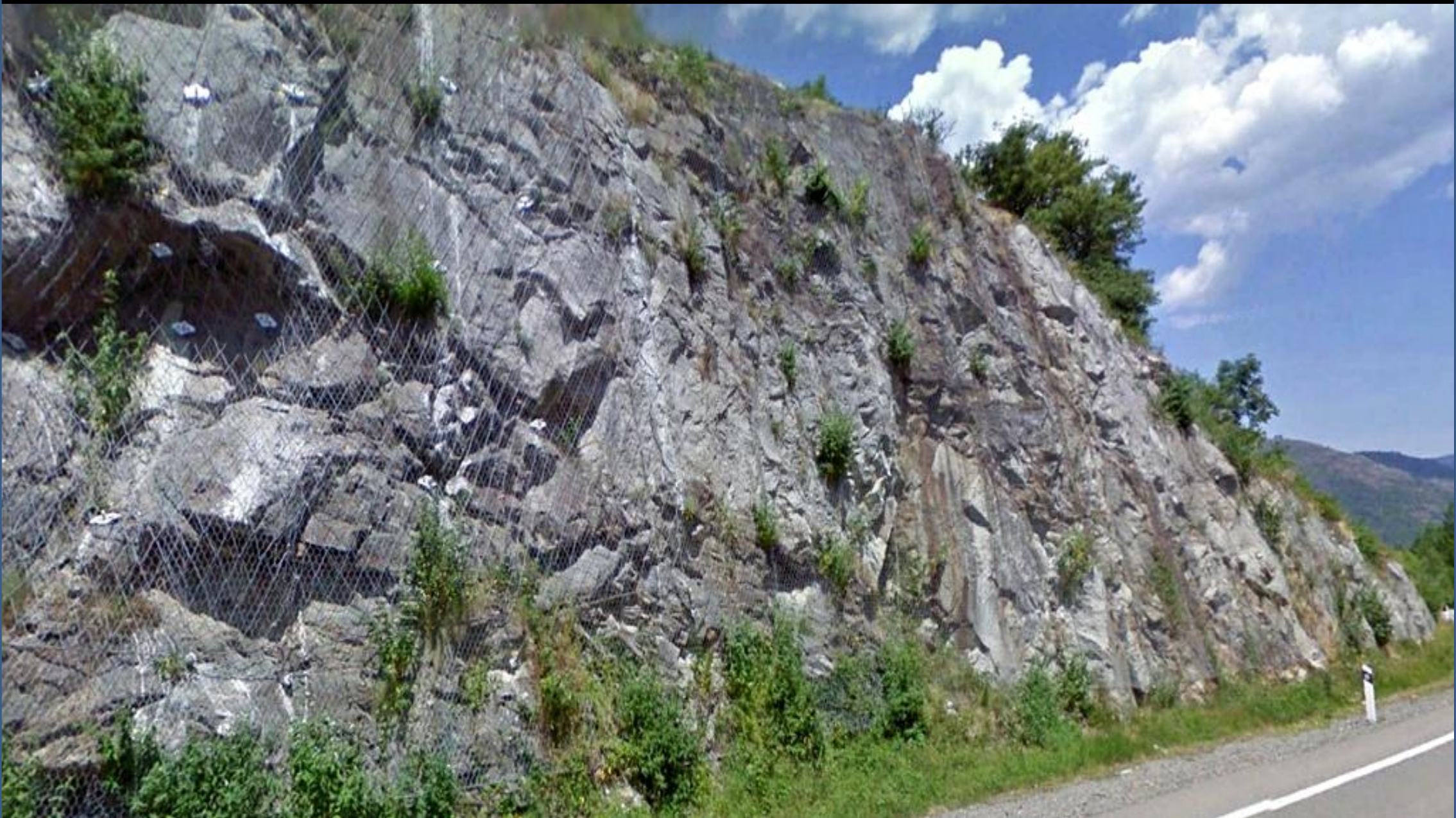
Leucogranitos, domo de Bossost. Bulonado y mallazo. Junto al Río Garona. NE Hoja de Vielha.
