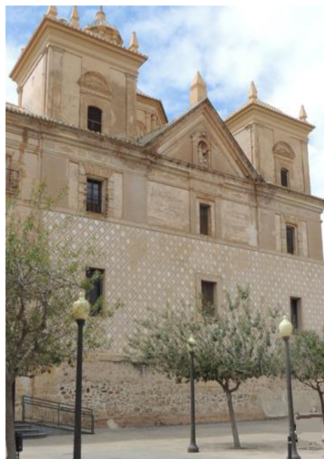
Fig. IV-23 fachada posterior Iglesia (Autor)
