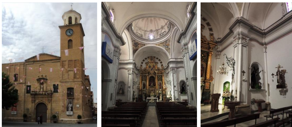
Fig. IV-69 Fachada frontal, nave vista desde los pies de la iglesia y pilastra del crucero. (Autor)
