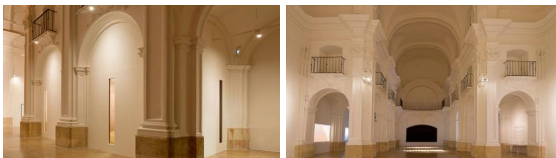
Fig. IV-60 Zona de acceso a nave y fondo de la nave y capillas laterales, con el coro alto de la antigua iglesia.
