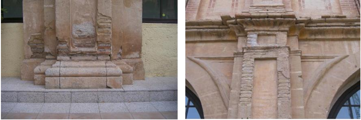
Fig. IV-42 Pilastras cajeadas en la fachada al patio del claustro (Autor)
