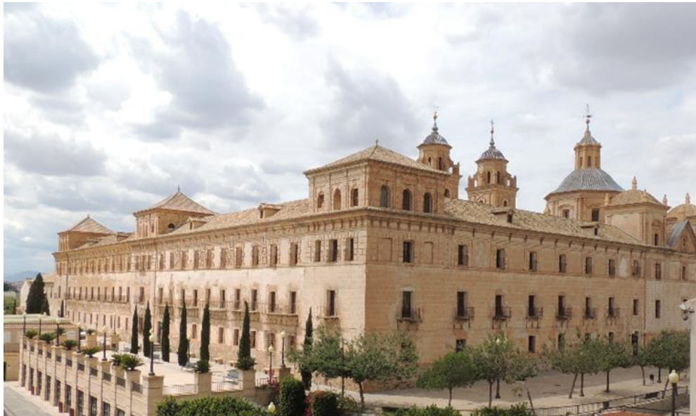
Fig. IV-3. Esquina de fachadas NE/SE. (Autor)
