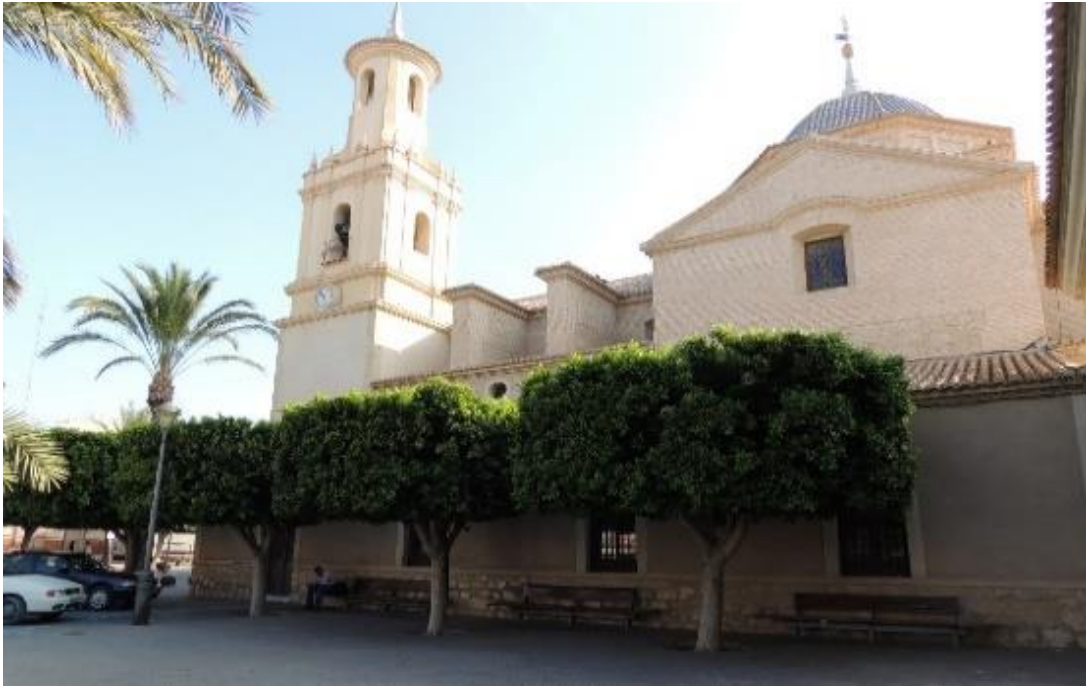
Fig. IV-66 Vista lateral de la iglesia de la Purísima Concepción en Fortuna. (Autor)
