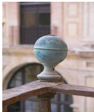
Fig. IV-12. Remate de balcón de claustro. (Autor)
