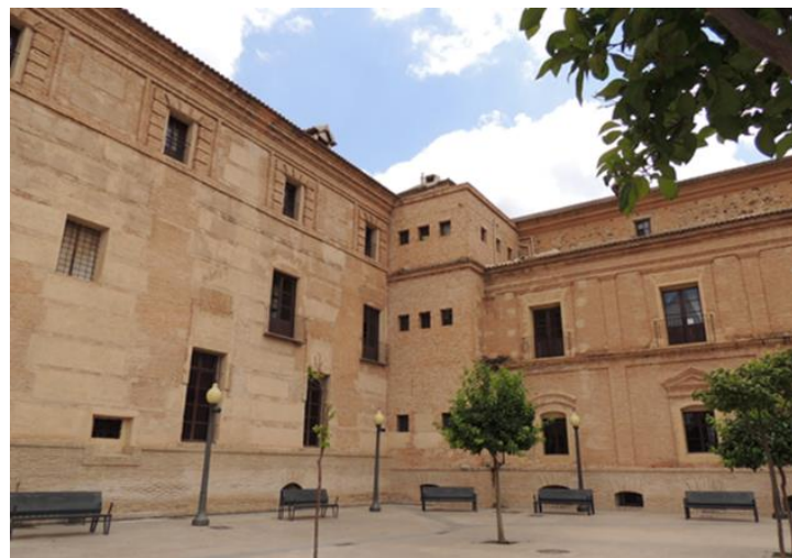
Fig. IV-4. Estado actual del claustro de la hospedería. (Autor)
