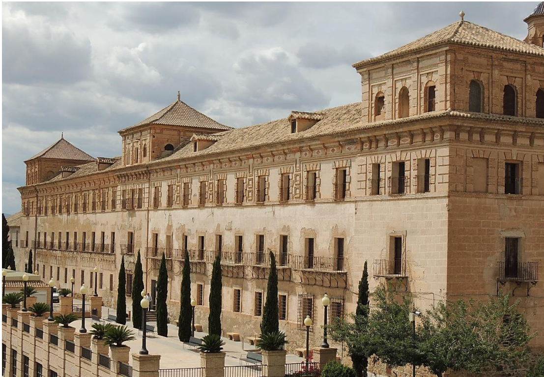
Fig. IV-41 Fachada sureste (Autor)
