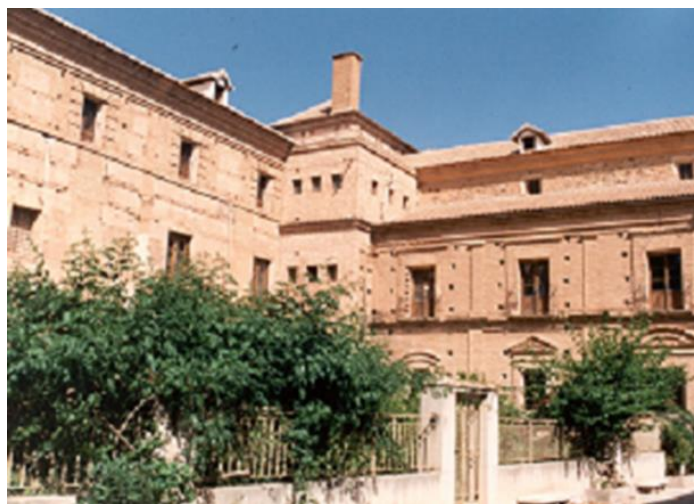
Fig. IV-2. Fachada del claustro inacabado (J.C. y J.C.C 1997)
