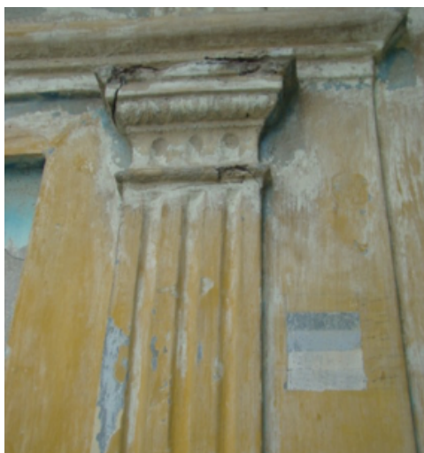
89. Detalle de la toma de muestra sobre paramento liso. Edificio Antiguo Almacén Ley.( Rossana Llanos).
