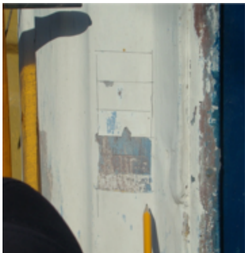
87. Proceso de toma de muestras . Edificio Antiguo Banco Dugand.( Rossana Llanos).
