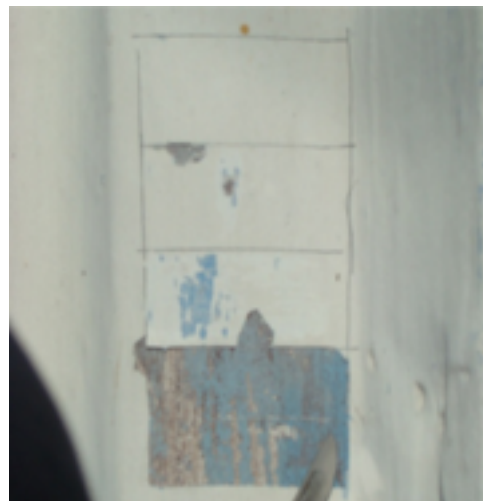
88. Calas estratigráficas Edificio Antiguo Banco Dugand.( Rossana Llanos).
