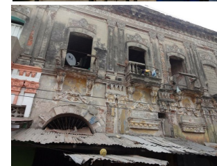
Fotografía estado actual
