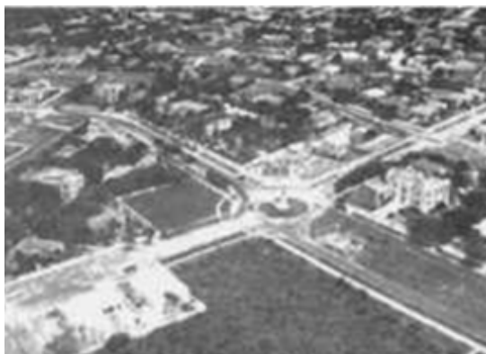
32. Vista del Barrio El Pardo , Boulevard Carrera 54.(Consuegra 2003)
