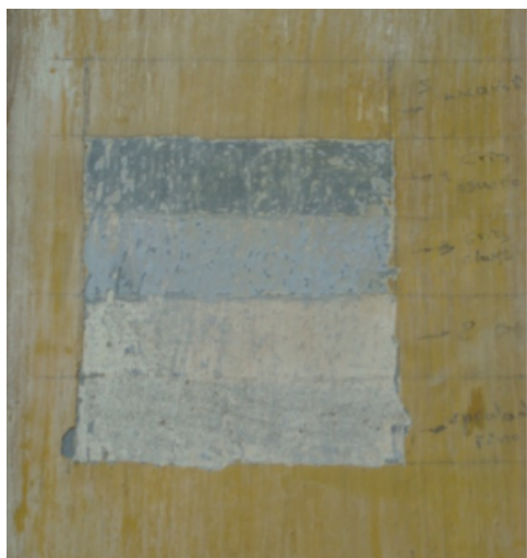
89. Detalle de la toma de muestra sobre paramento liso. Edificio Antiguo Almacén Ley.( Rossana Llanos).
