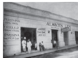
Primera etapa de construcción del Edificio Década de los Años 10's aprox.
