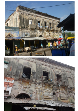
Fotografía estado actual
