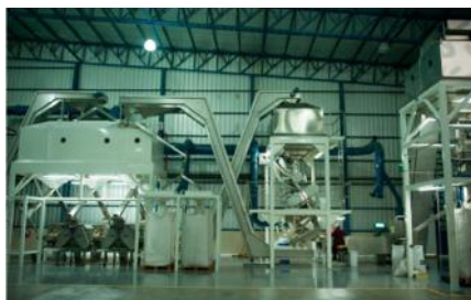
Tolva de alimentación y blanchers
