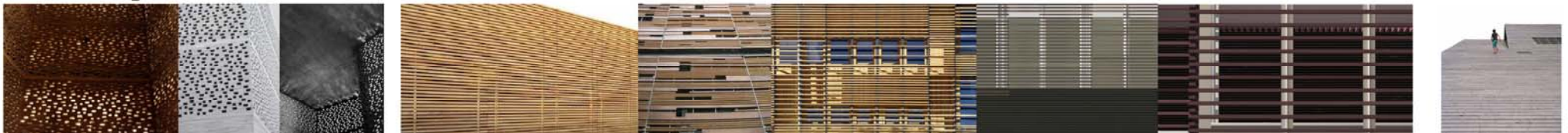
diversa tipología: cerramiento opaco, cerramiento conformando taracea para entrada de luz difusa, lamas de despiece horizontal fijas y móviles, acabado superficial de cubierta
