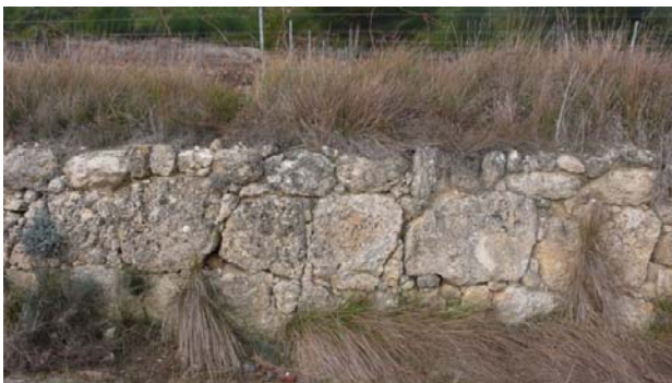
Muro de piedra seca
