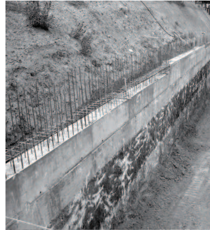
Mur de soterrani
