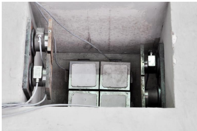
Figura IV-27. Vista del interior del cáliz antes del posicionamiento del pilar
