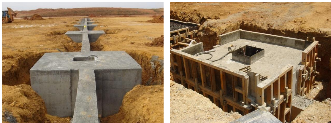
Figura I-1. Cálices de cimentación ejecutados in situ
