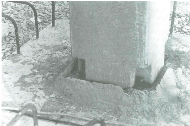
Figura II-7. Esquema de unión con chapa enrasada [8] | Pilares con chapa enrasada [8]
