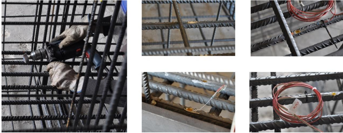
Figura IV-22. Pulido, pegado de galgas, colocación de bridas e identificación de cables
