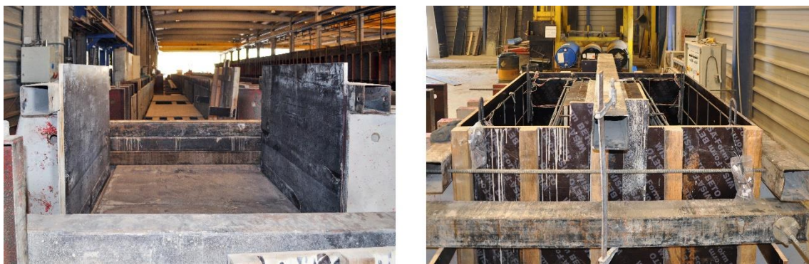
Figura IV-24. Encofrado de los especímenes
