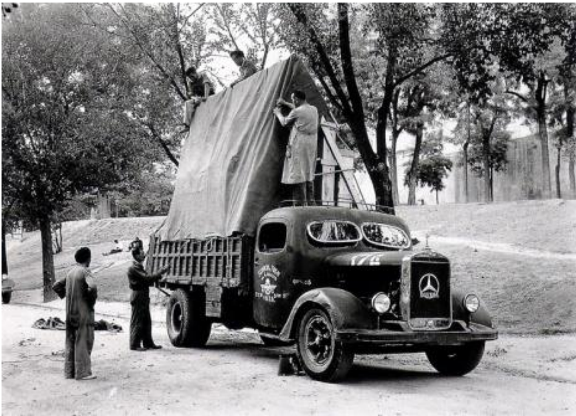
Fig.: 8. Restauradores sacando las obras de las zonas conflictivas.
