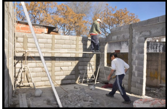
Figura 7. Casa de Bloque de Concreto.
