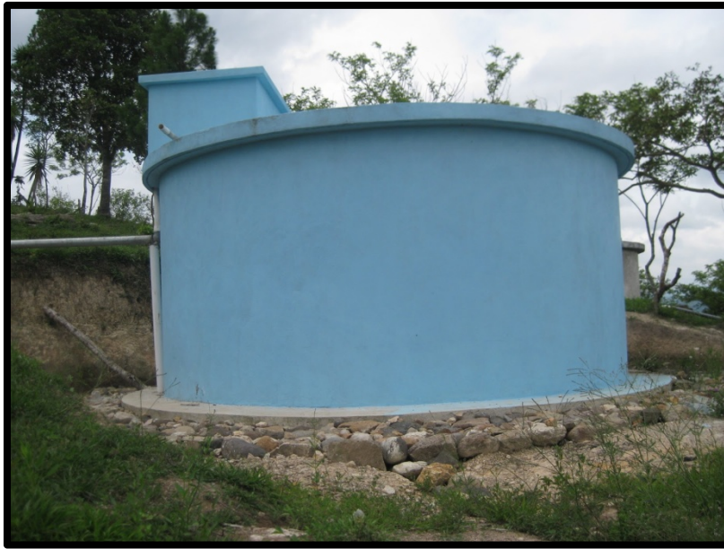
Figura 1. Tanque de Almacenamiento de Agua.
