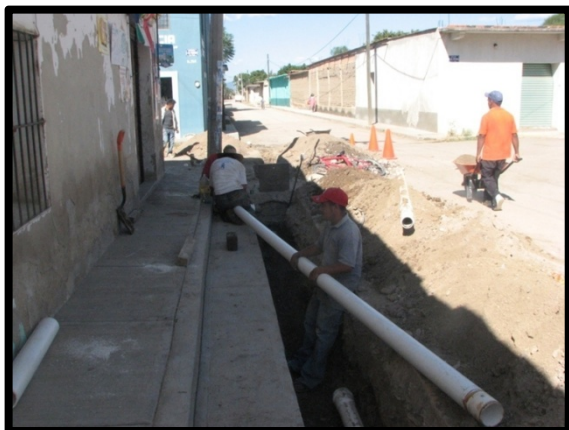
Figura 4. Colocación tubería de PVC.
