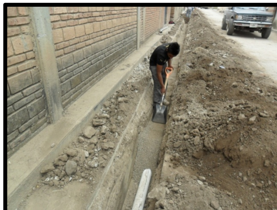
Figura 5. Colocación y relleno de tubería de PVC.
