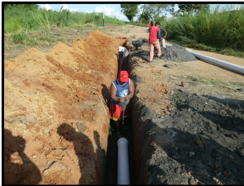
Figura 3. Colocación tubería de PVC biorientada.
