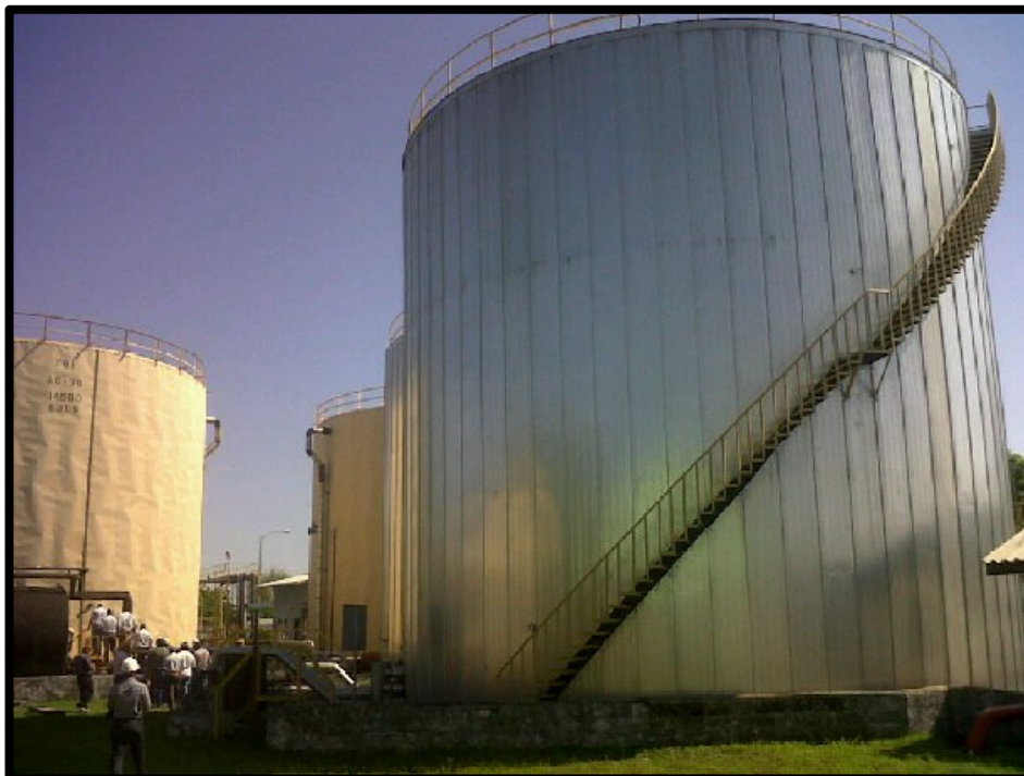
Figura 15. Fábrica de Asfalto UnoPetrol, Omoa
