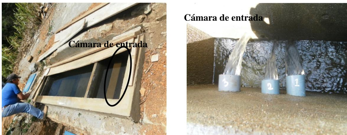
**Figura 5. 8** Tanque recolector y desarenador
