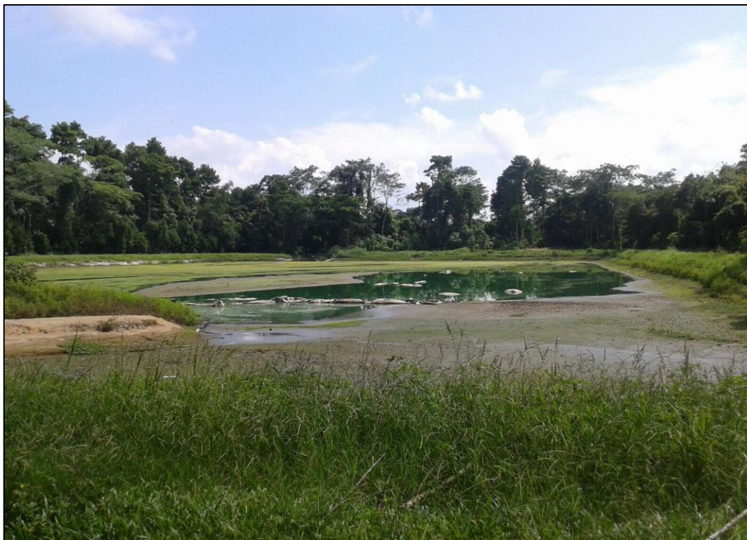
Figura 21. Laguna de oxidación facultativa en Tibú Colombia . Fuente: SGS Colombia S.A. (2015). Registro Fotográfico
