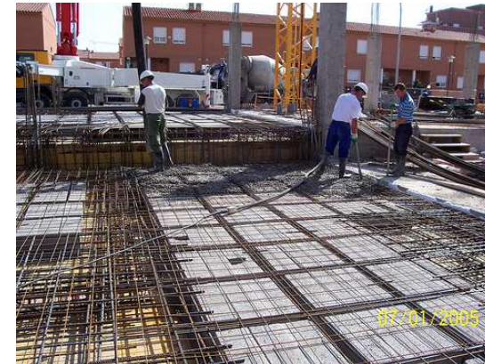
Montaje del forjado
