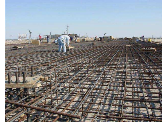
Montaje de las armaduras
