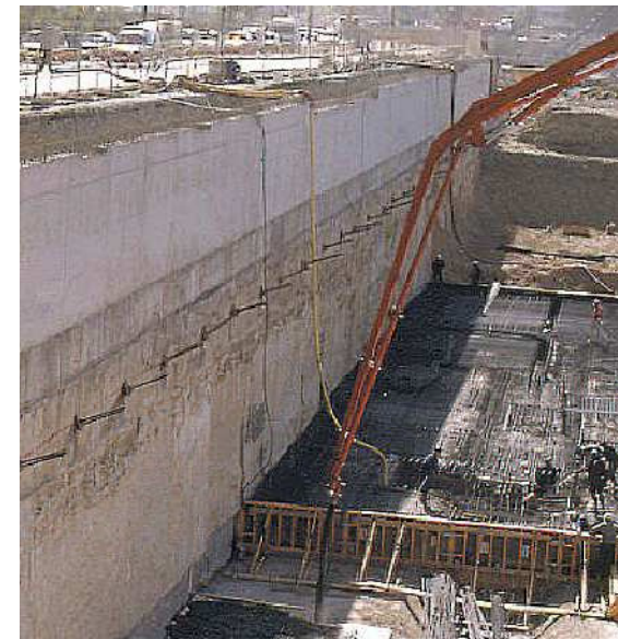
Ejecución del muro de contención
