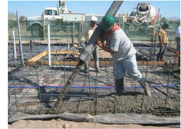
Hormigonado con bomba
