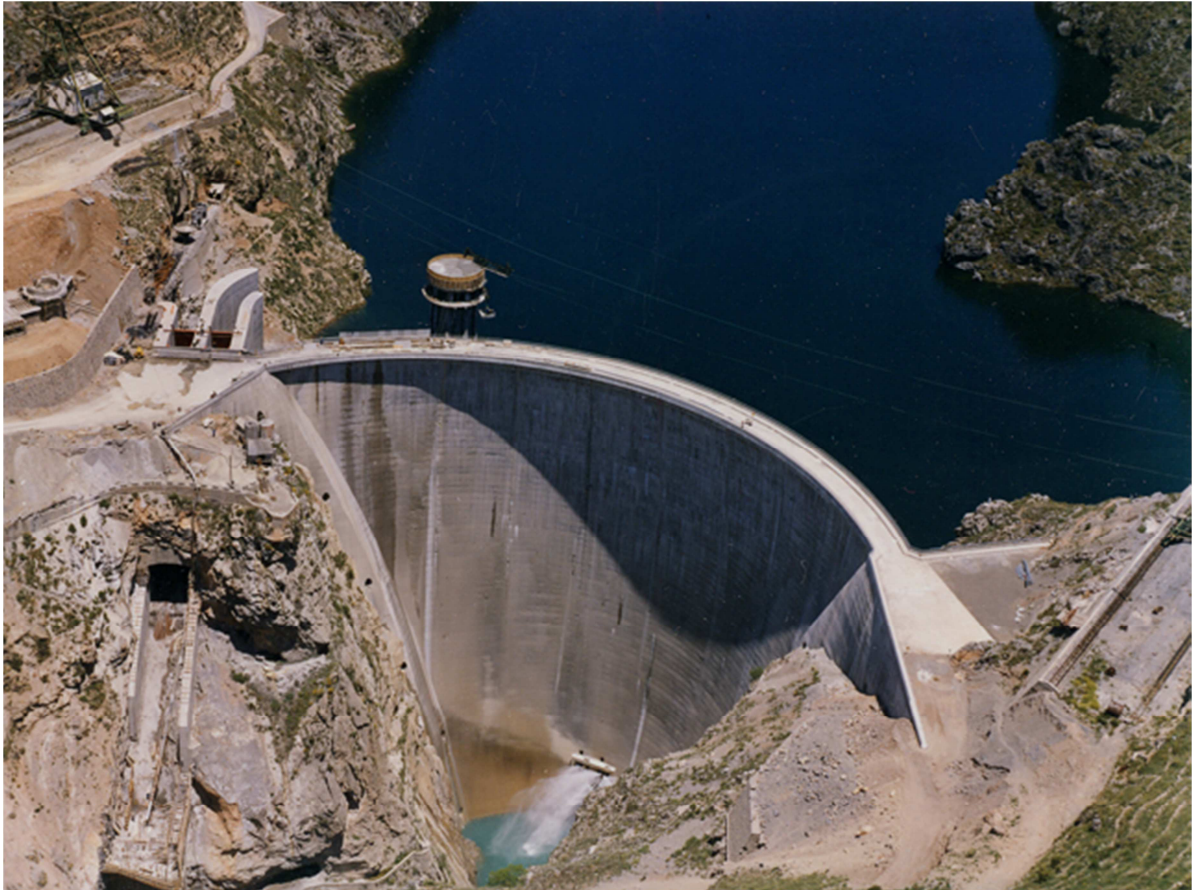
Figura 11: Vista general de la presa de Quéntar. (Fuente: ref.[17])
