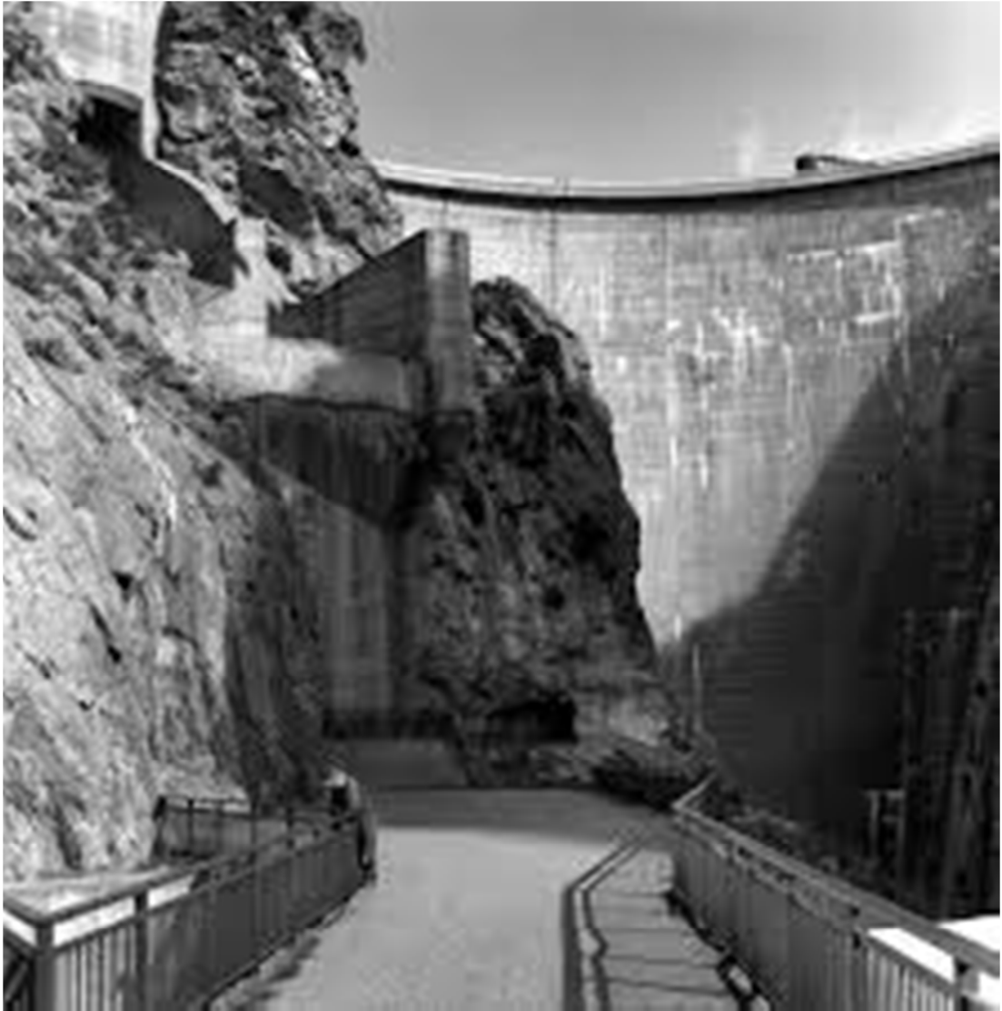
Figura 1: Vista de la presa de Quéntar desde aguas abajo (Fuente: ref.[17])
