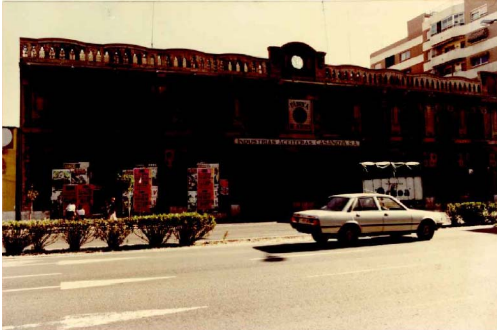
Foto 67: Naves de tratamiento de aceites y grasas para usos industriales. Industrias aceiteras Casanova. Avda. del Puerto, 253. Valencia. 1985. Fuente: Elaboración propia
