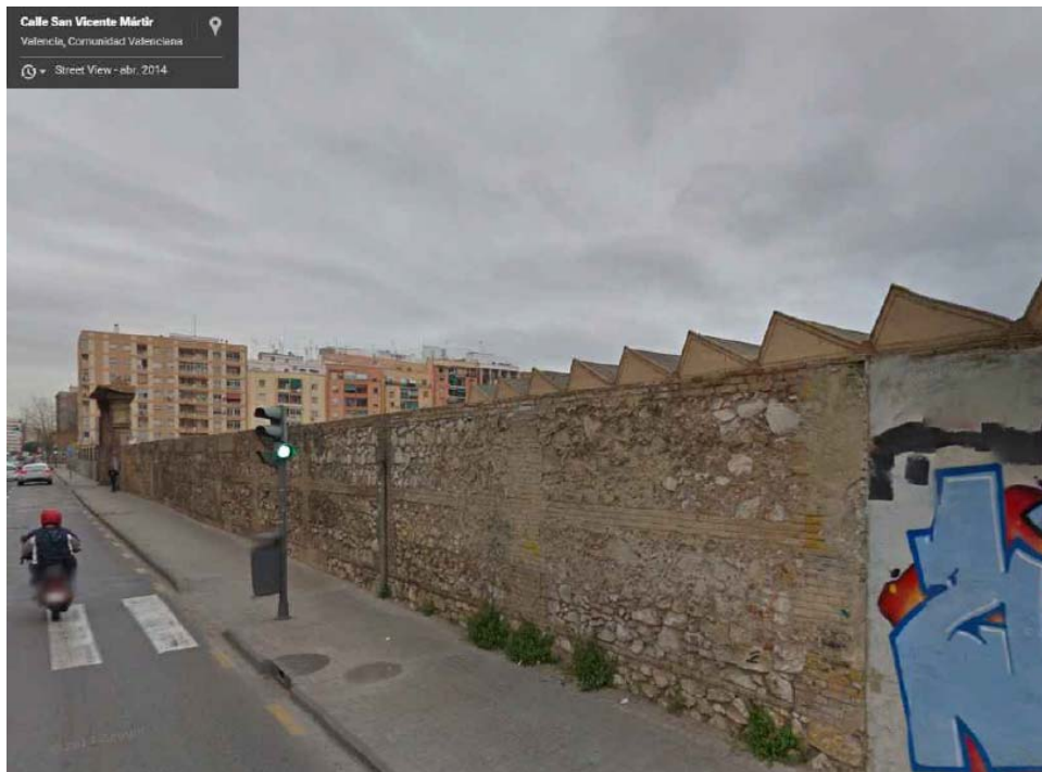
Foto 52: Solar. Antigua ubicación MACOSA. C/ San Vicente Mártir, 269. Valencia. 2014 Fuente: WEB. http://www.google.es/maps (Street View).
