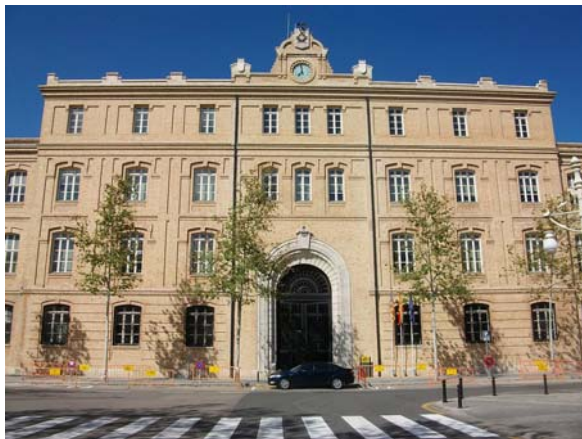
Foto 92: Ayuntamiento Valencia. Antiguo Palacio de la Industria. C/ Amadeo de Saboya. Valencia. 2015. Fuente: WEB. http://www.google.es/maps (Street View).
