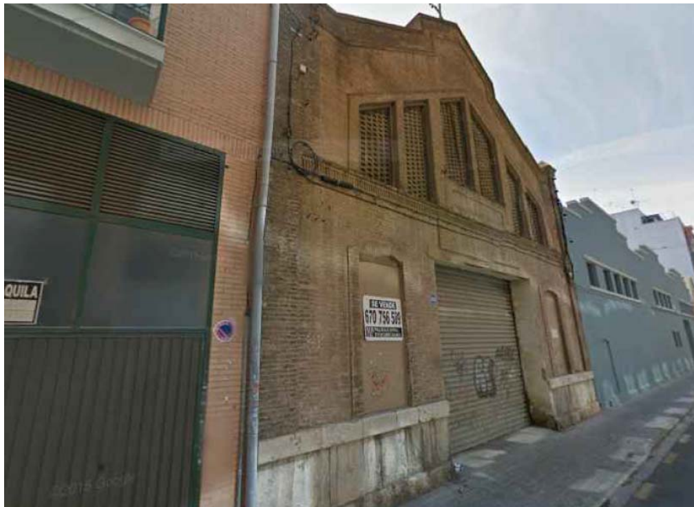
Foto 62: Antigua industria de madera. Duraglia. C/ Lirio, 11. Valencia. 2015 Fuente: WEB. http://www.google.es/maps (Street View).
