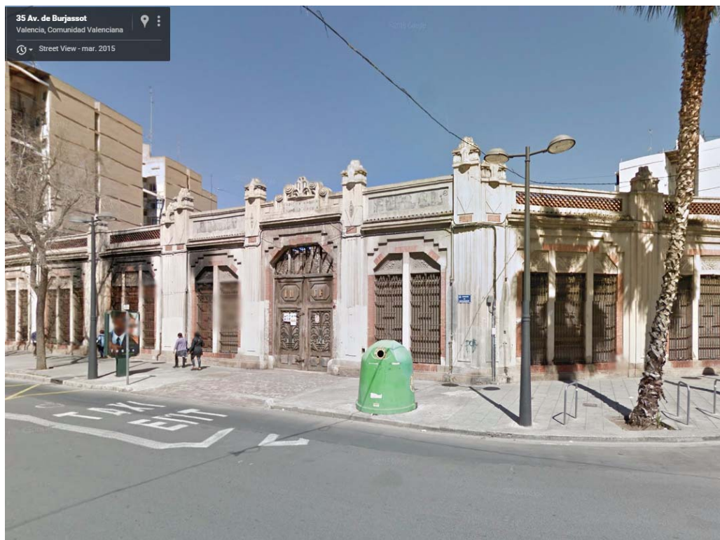
Foto 24: Antigua fábrica de bombas y válvulas Carlos Gens, S.L. Avda. Burjasot, 54. Valencia.2015 Fuente: WEB. http://www.google.es/maps (Street View)
