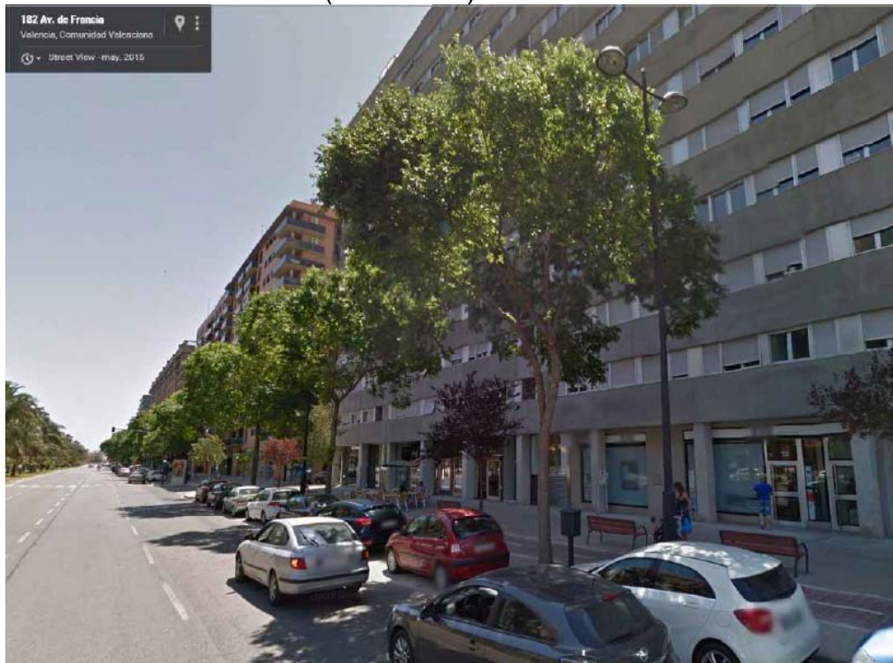
Foto 75. Edificios residenciales. Avda. de Francia. Valencia.2015. Fuente: WEB. http://www.google.es/maps (Street View).
