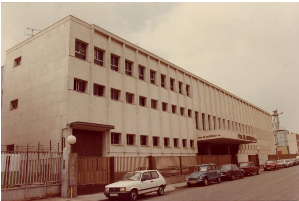
Foto 30: Fábrica de muebles Vda. De Hurtado. C/ dels Fusters, 1. Polígono industrial Vara de Quart Valencia. 1985. Fuente: Elaboración propia
