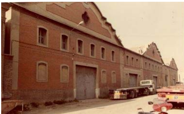
Foto 17: Naves almacén. C/ Juan Verdeguer, 16 al 24. Valencia. 1985 Fuente: Elaboración propia
