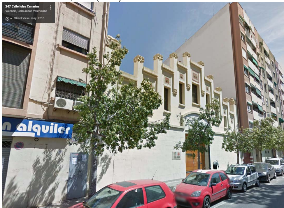
Foto 77. Centro Municipal.C/ Islas Canarias, 247. Valencia.2015. Fuente: WEB. http://www.google.es/maps (Street View).
