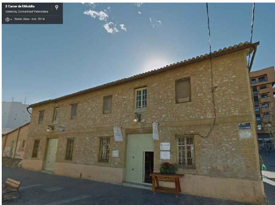
Foto 44: Edificio industrial. C/ Alcudia de Carlet, 3. Valencia. 2014 Fuente: WEB. http://www.google.es/maps (Street View).
