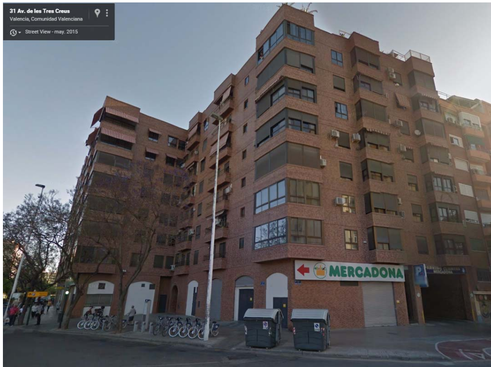
Foto 28: Edificio residencial. Avda. Tres Cruces, 25. Valencia.2015 Fuente: WEB. http://www.google.es/maps (Street View).
