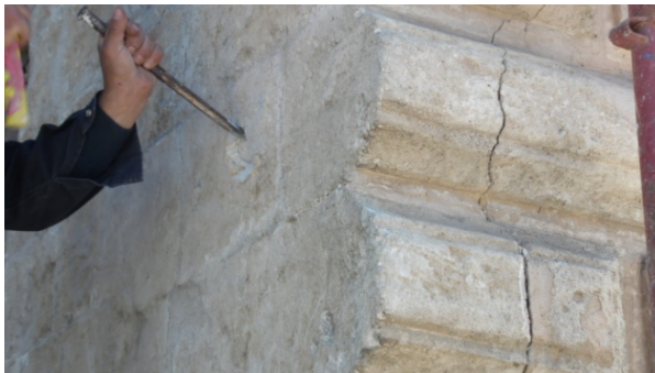
Fig.1 Saggio di ricerca dell'armatura nelle perforazioni.
