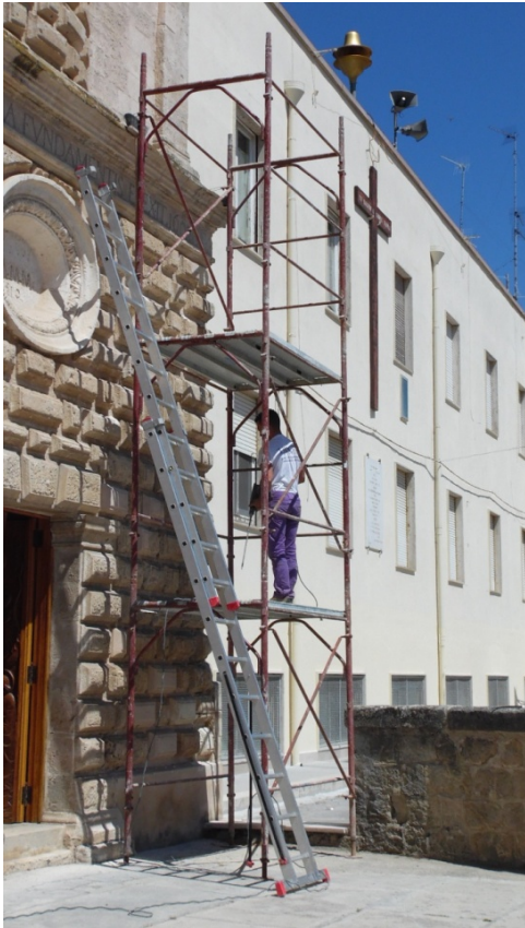
Fig.6 Fasi preparatorie; opere provvisionali.
