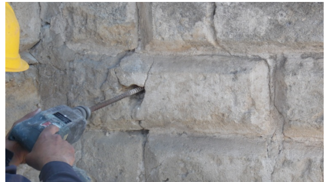
Fig.8 Riapertura per ispezione di una perforazione armata
