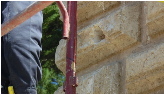
Fig.9 Foro predisposto e pulito da impurità.
