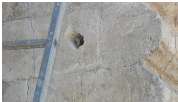
Fig.3 Saggio di ricerca dell'armatura nelle perforazioni.
