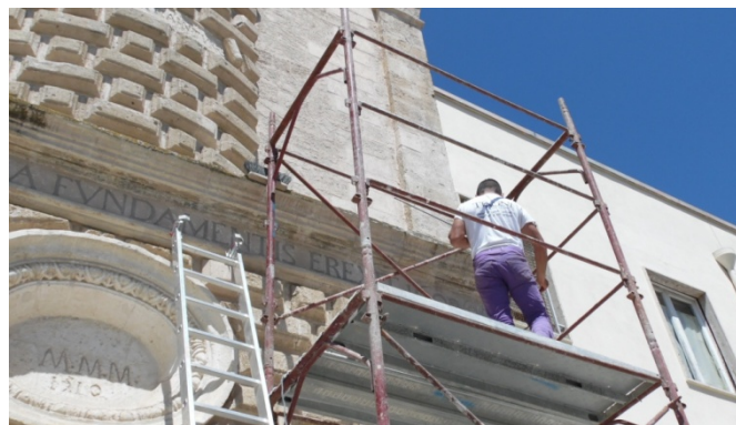
Fig.5 Fasi preparatorie; opere provvisorie.
