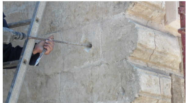
Fig.2 Saggio di ricerca dell'armatura nelle perforazioni.
