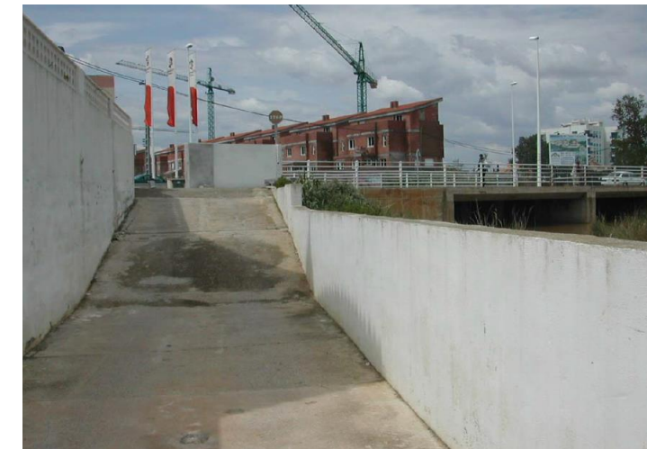
Figura 3. Estado de la zona.
