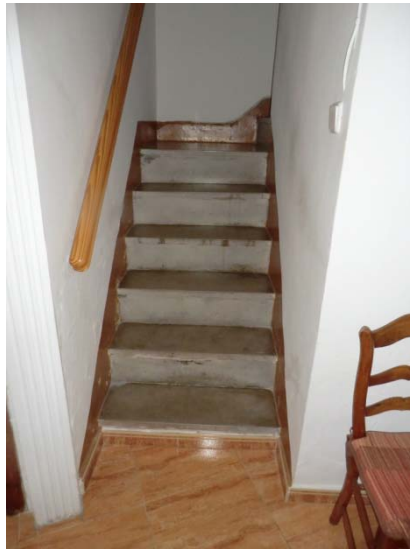
Escalera de acceso a planta primera que arranca desde el salón
