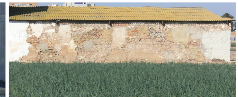
Figura 134. Muro de Tapial Calicastro. Perímetro este del patio de la alquería. Autor Propio 2015
