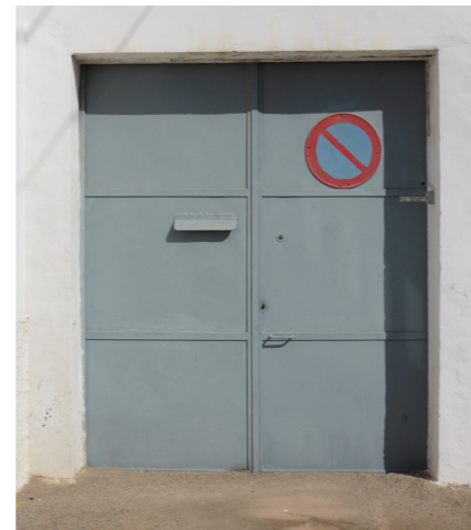
Figura 164. Puerta metálica de acceso al molino. Autor Propio 2015
