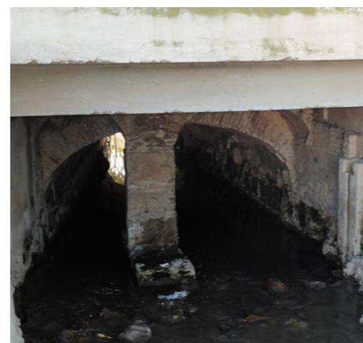
Figura 80. Entrada al cárcavo. Molí de Farinós. Autor Propio 2015
