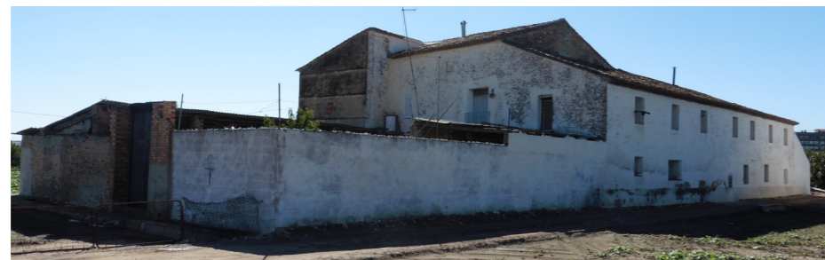
Figura 171. Vista general del edificio. Fachadas norte y oeste. Autor Propio 2015
