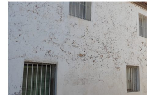
Figura 131. Muro de Mampostería. Fachada Oeste del edificio. Autor Propio 2015
