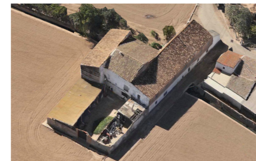
Figura 97. Molí de Farinós. Fachada Norte. Autor Propio 2015
