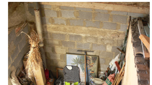
Figura 132. Muro de Bloque de Hormigón. Bloque anexo al molino en fachada sur. Autor Propio 2015
