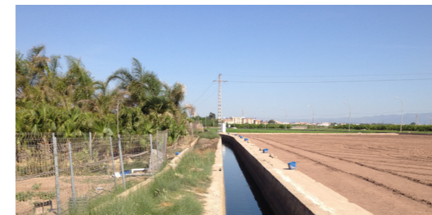
Figura 36. Tramo final de la acequia de Tormos, entre Carpesa y Tavernes Blanques. Autor Propio 2015
