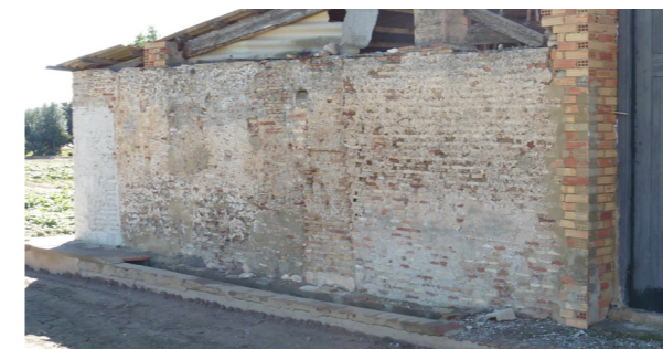
Figura 133. Muro perimetral de Tapial Calicastro del patio de la alquería. Autor Propio 2015
