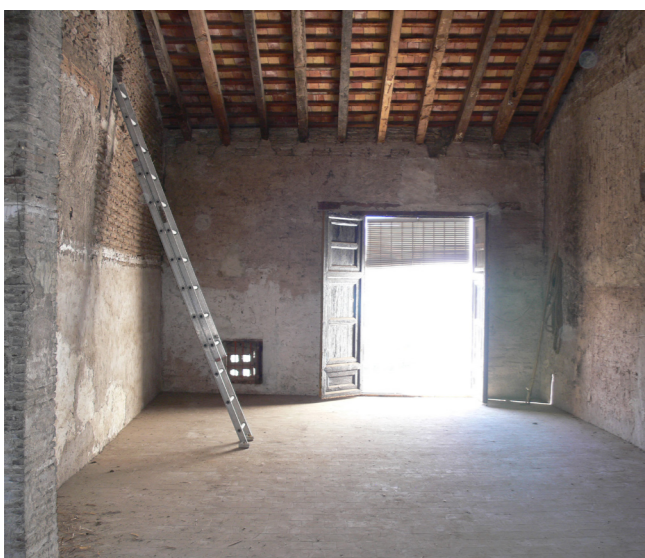
Figura 87. Entrada al cárcavo. Molí de Farinós. Autor Propio 2015
