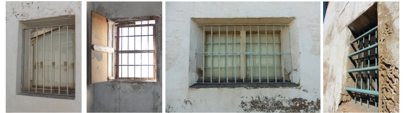
Figuras 150 - 153. Diferentes tipos de ventana y cerrajería en planta baja del edificio. Autor Propio 2015
