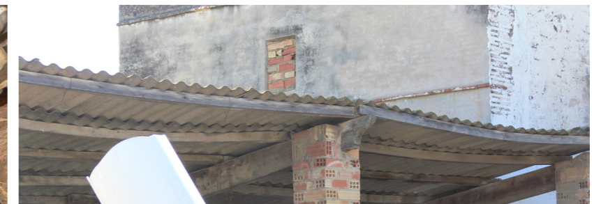
Figura 141. Cubierta de Fibrocemento en el patio de la alquería. Autor Propio 2015
