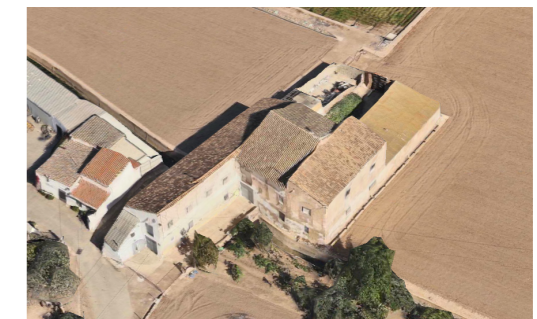
Figura 98. Molí de Farinós. Fachada Sur. Autor Propio 2015
