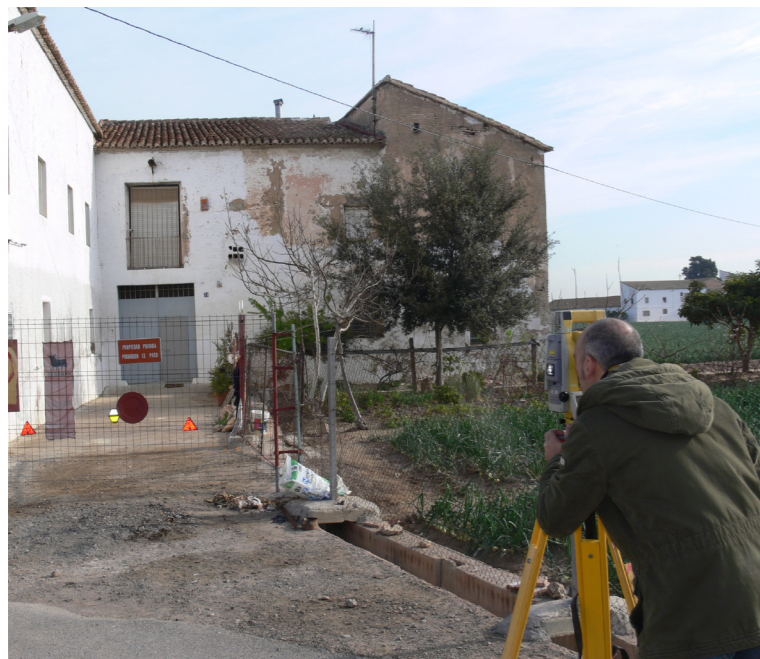
Figura 6. Obteniendo datos con la estación total. Autor Propio 2015
