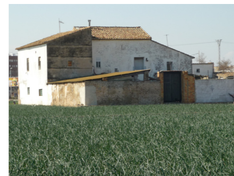
Figura 74. Alquería y Molí de Farinós. Fachadas Este y Norte. Autor Propio 2015
