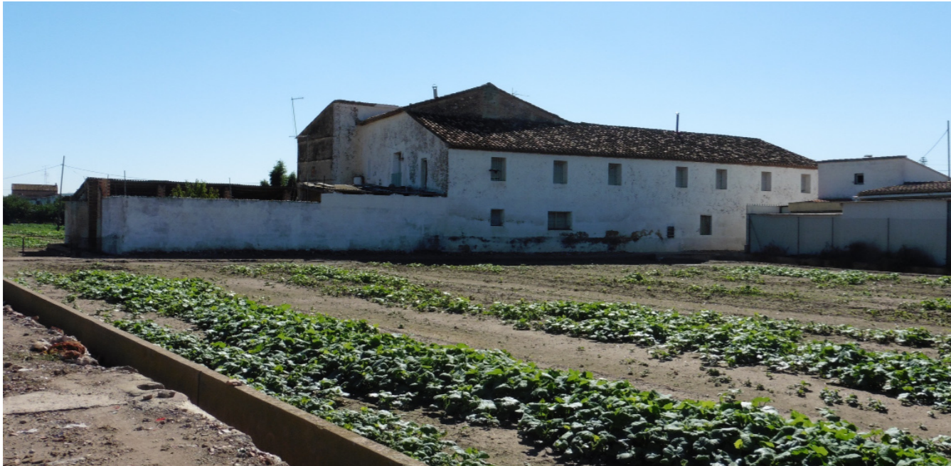
Figura 101. Edificio completo. Molino y alquería desde fachada oeste. Autor Propio 2015
