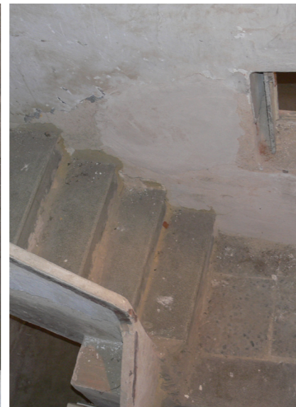
Figura 117. Escalera de bóveda tabicada para acceso a primera planta de la alquería. Autor Propio 2015
