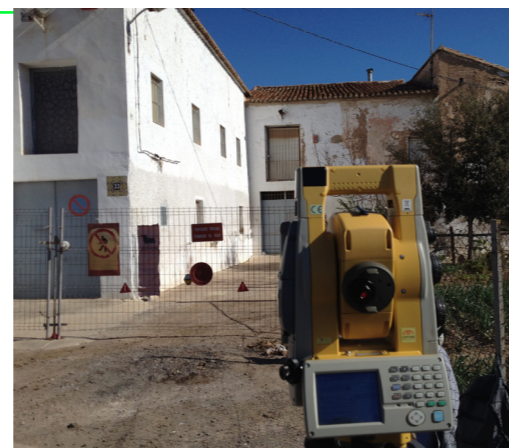
Figura 9. Estación total en posición. Autor Propio 2015
