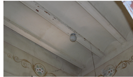
Figura 135. Forjado del edificio. Autor Propio 2015
