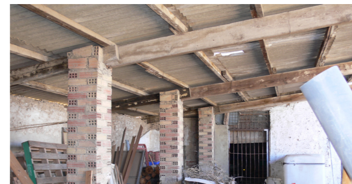
Figura 124. Cubierta a un agua de placas de fibrocemento en patio. Autor Propio 2015
