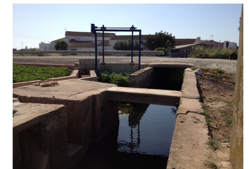
Figura 52. Partidor en la Acequia de Tormos. Autor Propio 2015
