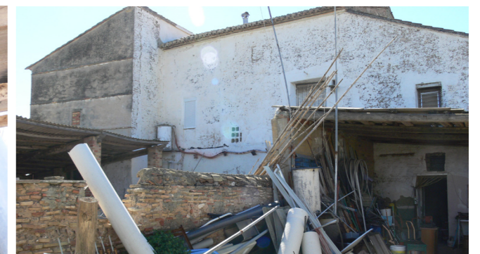
Figura 125. Cubierta de placas de fibrocemento en patio exterior. Autor Propio 2015
