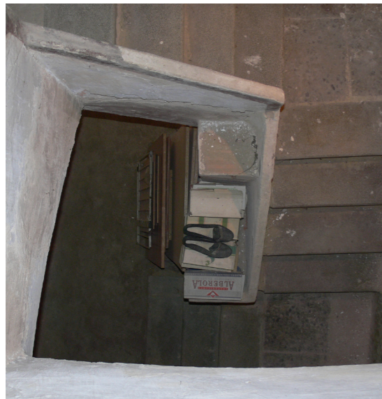
Figura 116. Escalera de bóveda tabicada para acceso a primera planta de la alquería. Autor Propio 2015
