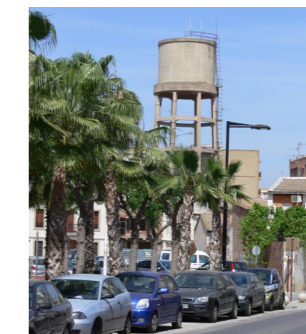
Figura 64. Antiguo depósito. Alboraya. Autor Propio 2015
