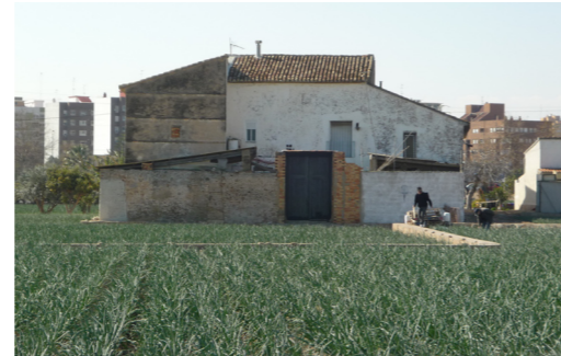
Figura 1. Molí de Farinós. Fachada Norte. Autor Propio 2015
