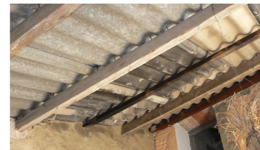
Figura 140. Cubierta de Fibrocemento en el bloque suroeste del edificio. Autor Propio 2015
