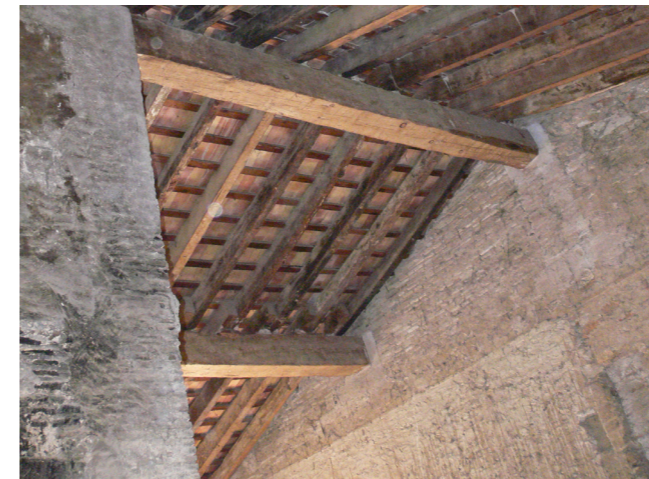
Figura 138. Cubierta a dos aguas del cuerpo central de la alquería. Autor Propio 2015
