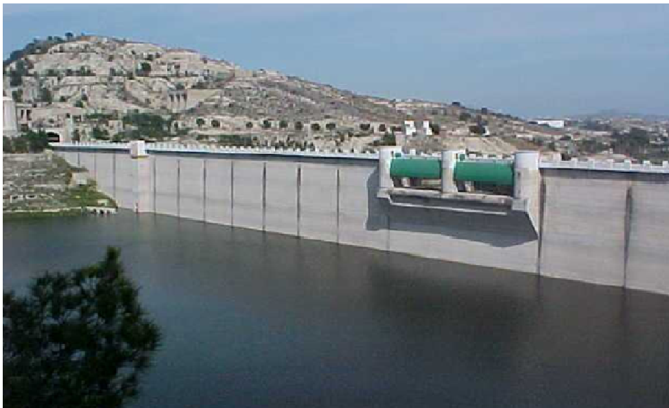
Figura 5.1- Vista de la presa 01 desde aguas arriba.
