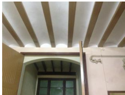
Figura 45. Disposición de la viguetas en el forjado de la primera planta. 2016. In Situ.
