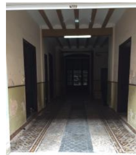
Figura 46. Disposición de la viguetas en el forjado de la primera planta. 2016. In Situ.
