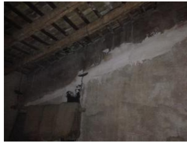
Figura 41. Cubierta vista desde el interior. 2016. In situ.
