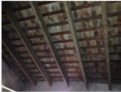
Figura 40. Cubierta vista desde el interior. 2016. In situ.
