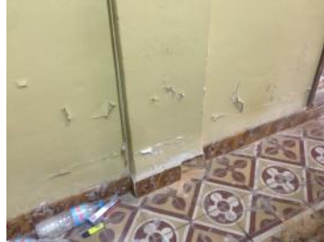
Figura 34. Pavimento pasillo. 2016. In Situ.
