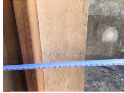
Figura 29. Espesor de muro de carga. 2016. In Situ
