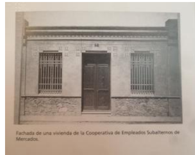
Figura 18. Fachada de una vivienda de la Cooperativa de empleados. Vivienda Obrera y Crecimiento Urbano (Valencia 1856-1936).
