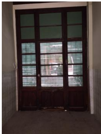
Figura 38. Puerta acceso al patio. 2016. In Situ.
