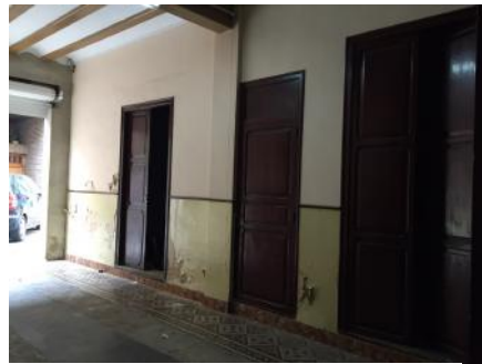
Figura 39. Carpintería interior. 2016. In Situ.
