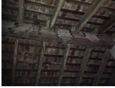
Figura 43. Viga en cumbrera. 2016. In Situ.
