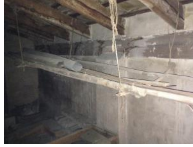
Figura 44. Viga encuentro entre el alero y el paramento vertical. 2016. In Situ.
