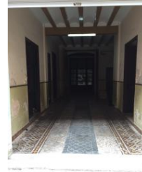
Figura 35. Pavimento pasillo. 2016. In Situ.
