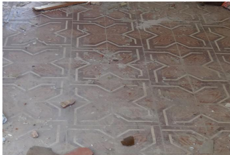
Ilustración 38. Detalle suelo salón (Fuente propia)
