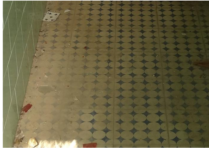
Ilustración 36. Detalle suelo baño (Fuente propia)
