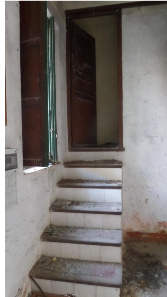
Ilustración 18. Escalera de acceso a la planta primera (Fuente propia)
