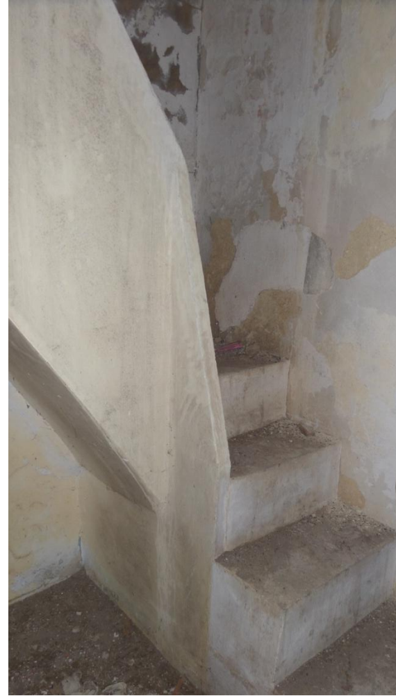
Ilustración 17. Escalera de subida a la torre forestal (Fuente propia)
