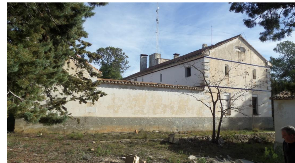
Ilustración 52. Detalle de la exfoliación de la ilustración 48 (Fuente propia)
