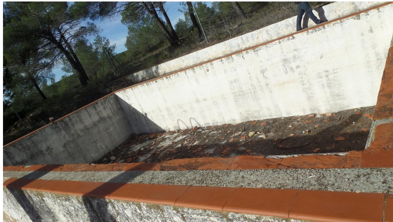
Ilustración 22. Piscina, Edif. V (Fuente propia)
