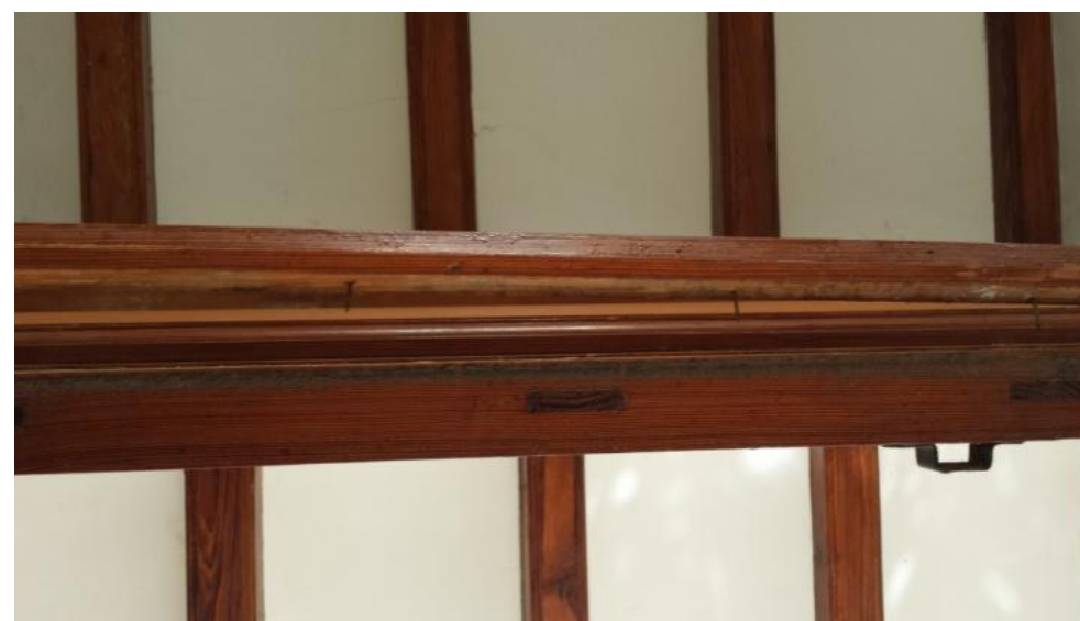
Ilustración 26. Detalle del entrevigado (Fuente propia)
