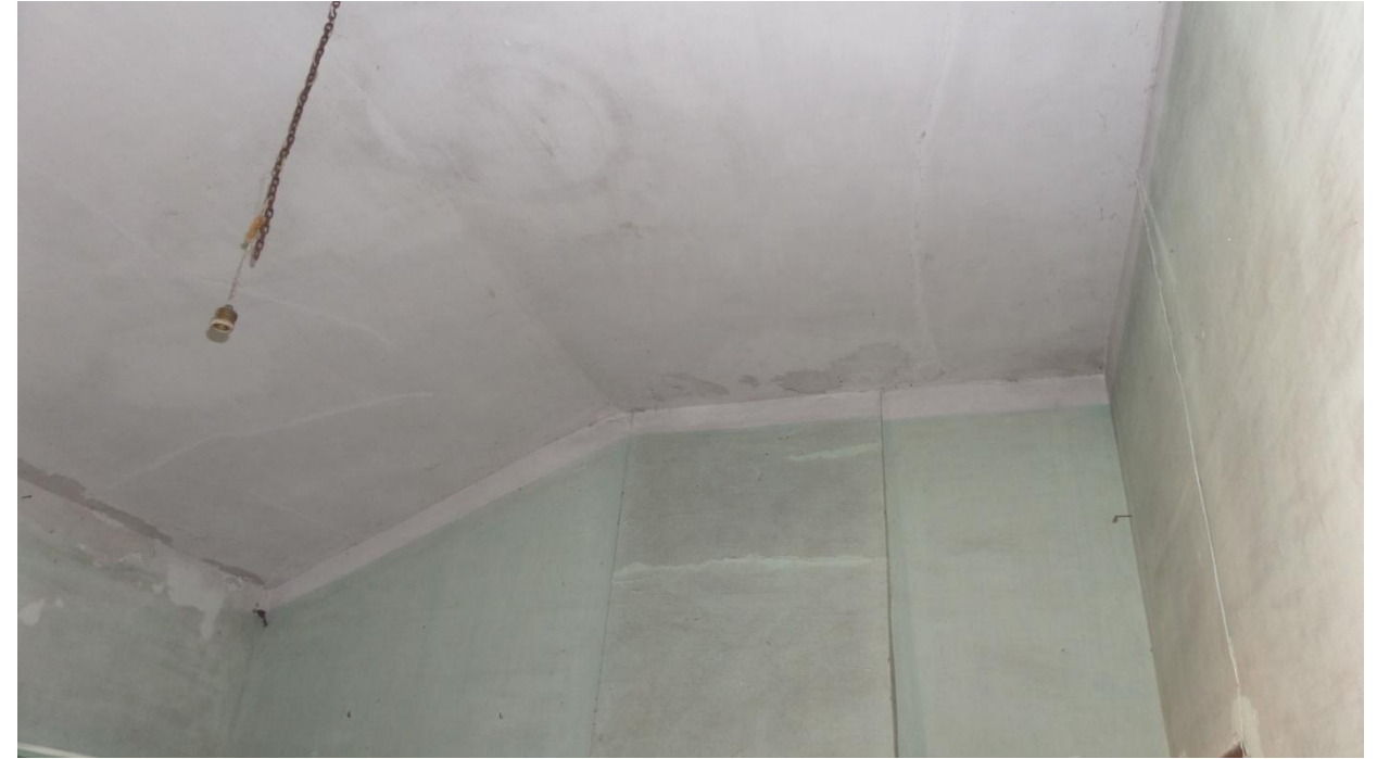
Ilustración 15. Detalle de cambio de plano en techo de la primera planta (Fuente propia)
