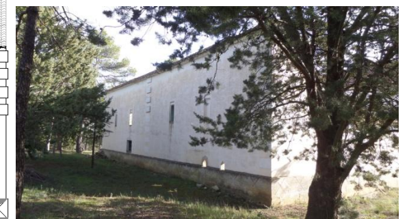
Ilustración 44. Fachada exterior Nord-Oeste (Fuente propia)
