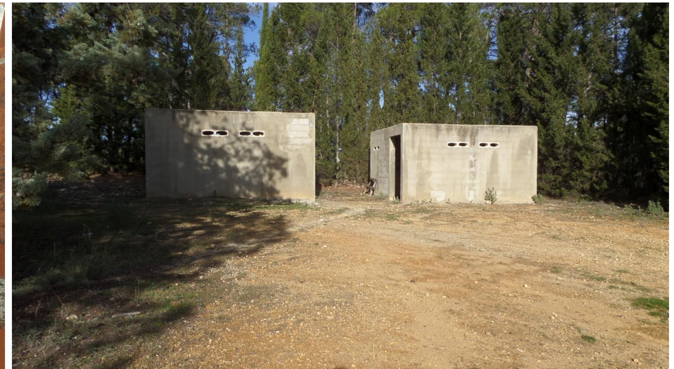
Ilustración 23. Baños, Edif.VI (Fuente propia)
