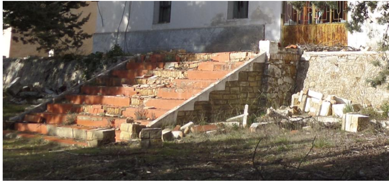
Ilustración 32. Detalle escalera exterior (Fuente propia)
