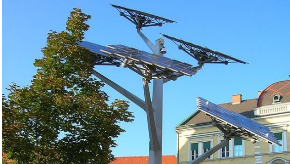
Ilustración 68. Aplicaciones de energía solar fotovoltaica. 2012. Rt
