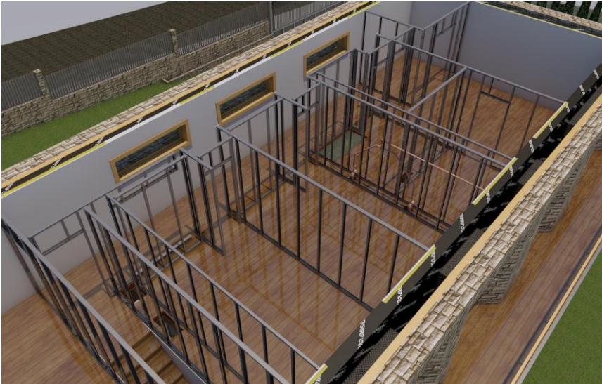
Ilustración 28. Instalación de perfilera autoportante. 2016. Fuente propia
