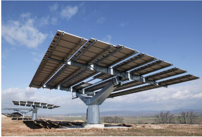
Ilustración 94. Torre seguidor solar. 2016. Ades
