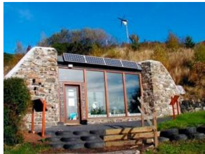
Ilustración 6. Vivienda integrada.2015. Oml
