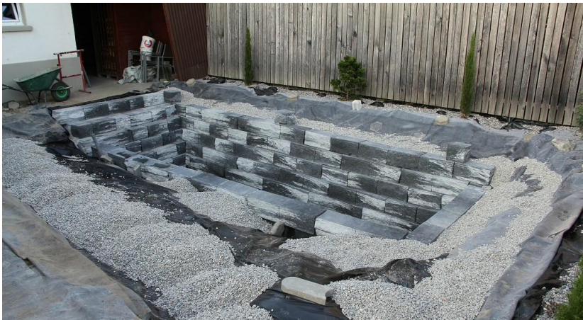
Ilustración 106. Muro vaso de piscina. 2015. Davidwolfe
