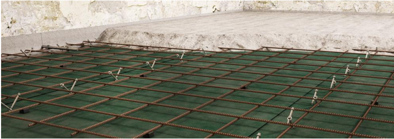
Ilustración 21. Forjado mixto. 2015. Rothbläss
