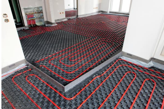
Ilustración 86. Instalación de suelo radiante. 2014. E-ficiencia
