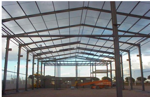
Figura 1. Nave industrial metálica en fase de ejecución.
