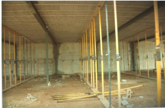
Figura 2. Ejecución de forjado en zona de oficinas.
