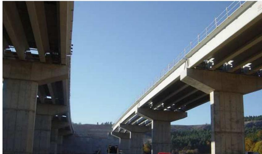
Figura 8. Fotografía tablero vigas prefabricadas
