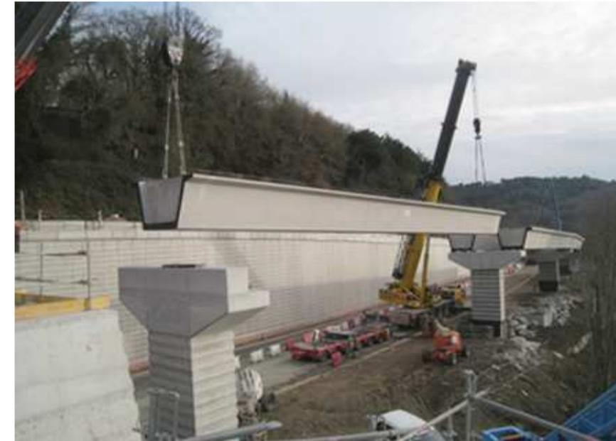
Fig. 10. Fotografía puente con viga artesa en construcción
