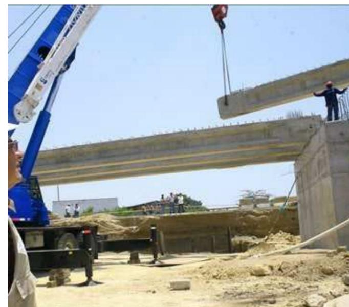
Fig.35. Elevación de vigas mediante grúa
