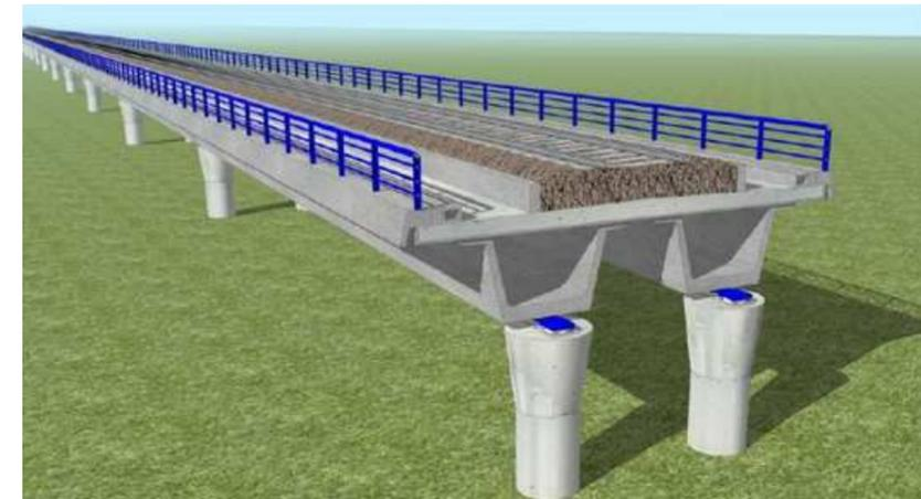
Fig. 20. Ejemplo Fuste para varias vigas.
