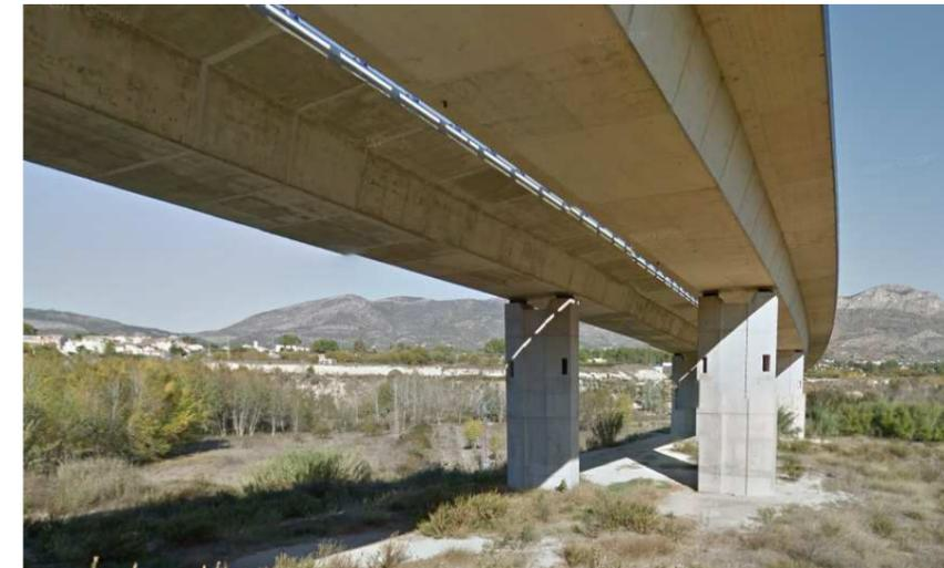
Figura 11 Tablero de viga cajón.
