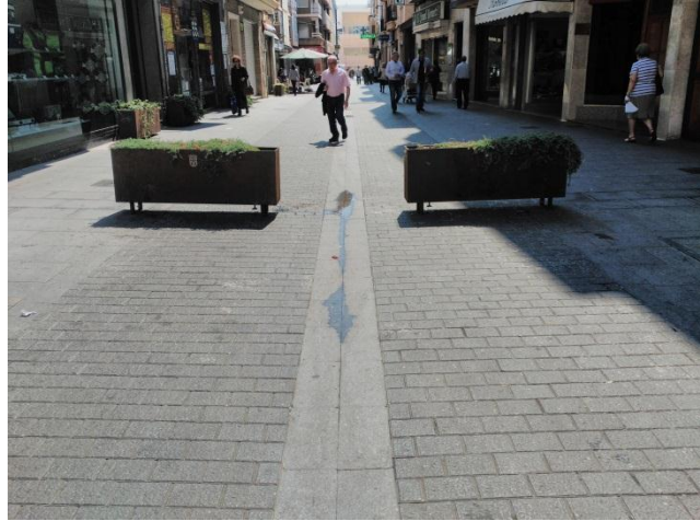
Imagen 3.53 Calle de Sagra urbanizada y adaptada con plataforma única
