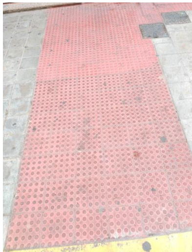
Imagen 2.10 Pavimento acera en mal estado en la calle El Salvador
