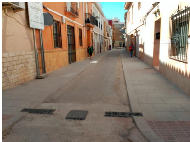
Imagen 3.45 Proceso de urbanización de la calle Virgen de los Dolores
