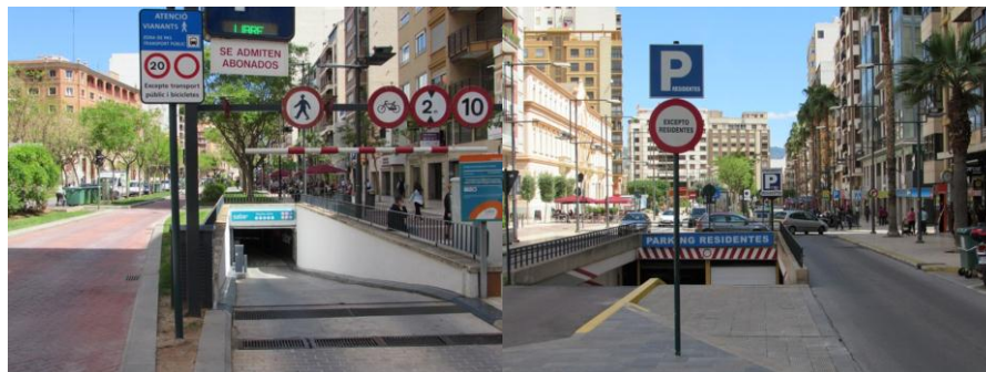
Imagen 3.22 Parking público de rotación Avenida Rey Don Jaime
