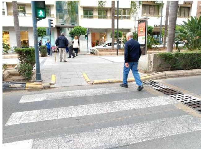
Imagen 2.21 Vado peatonal No accesible en Avinguda al Vedat
