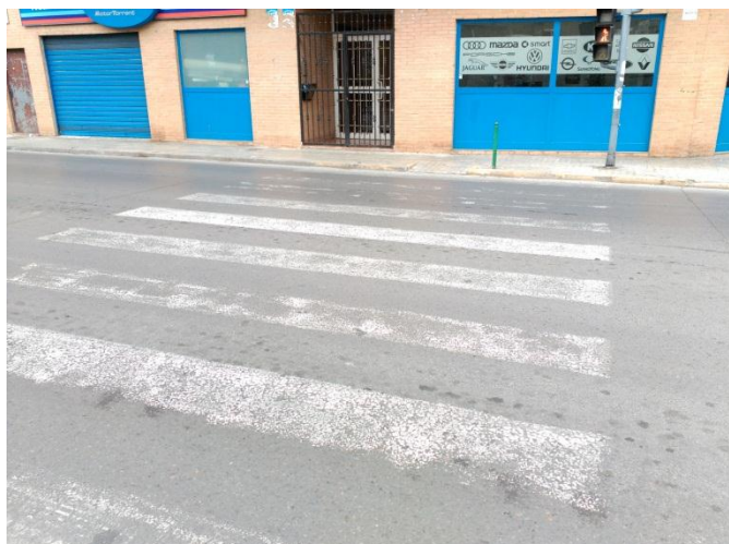
Imagen 2.32 Señalización horizontal en una vado peatonal en la calle Valencia
