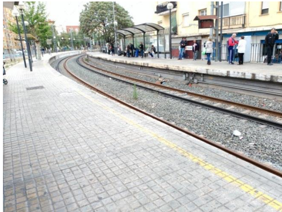
Imagen 2.52 Andén de la estación de metro de Torrent
