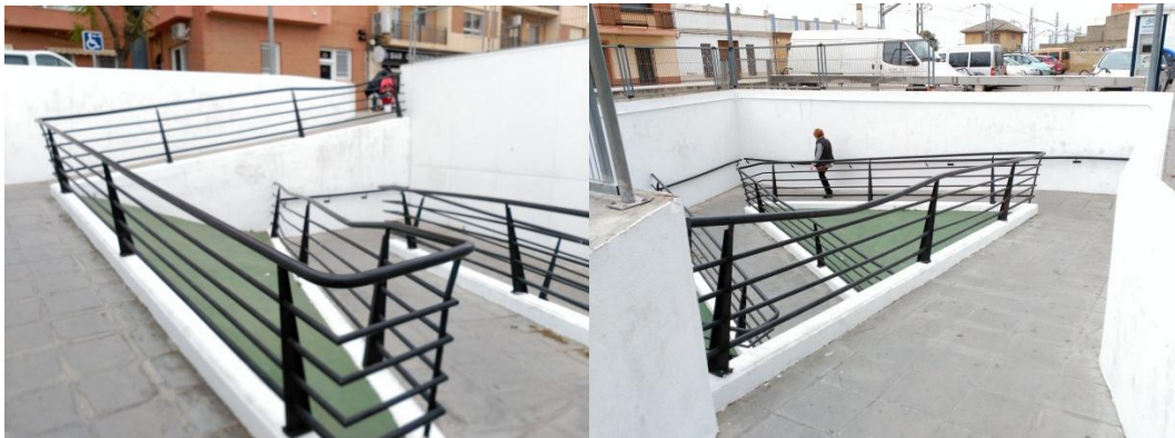
Imagen 2.23 Acceso a la estación de metro de Torrent
