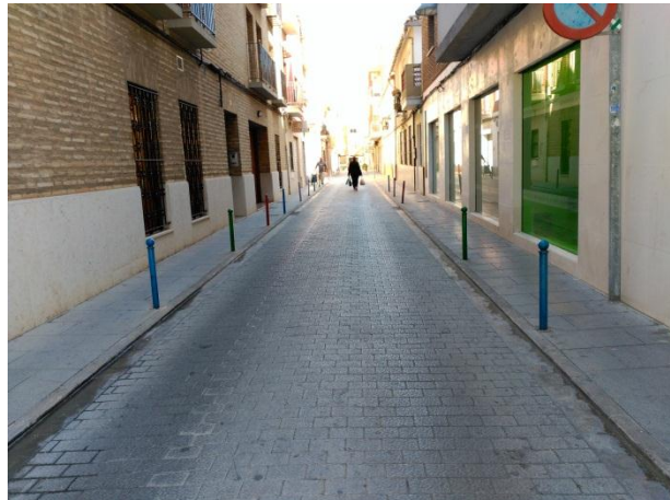
Imagen 3.43 Urbanización y adaptación calle Reyes Católicos
