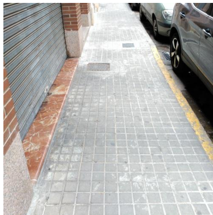
Imagen 2.9 Pavimento antideslizante acera calle San Jerónimo
