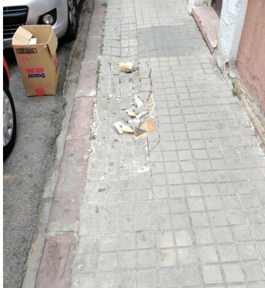
Imagen 2.10 Pavimento acera en mal estado en la calle El Salvador
