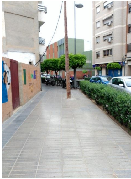
Imagen 2.24 Poste eléctrico en la calle Gómez Ferrer
