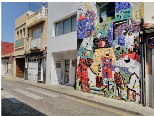
Imagen 3.46 Escuela infantil Casa Caridad de Torrent en calle Santa Lucia
