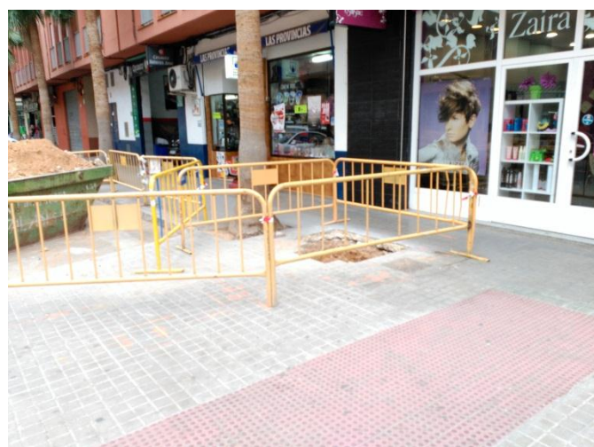
Imagen 2.43 Obras en la calle San Valeriano
