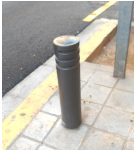
Imagen 2.37 Bolardos de hormigón reciclado con funda de plástico
