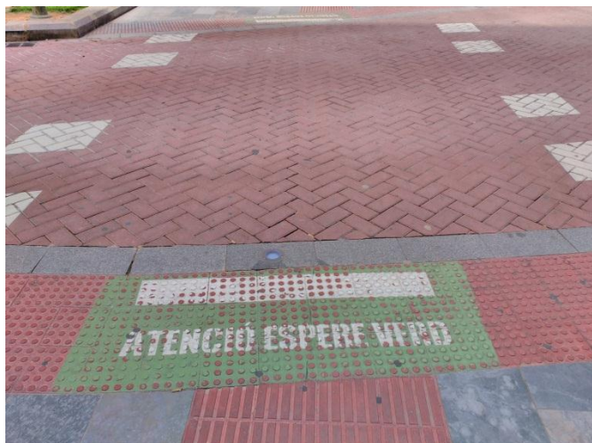
Imagen 3.16 Señalización vado peatonal en la Avenida Rey Don Jaime
