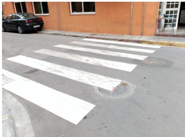
Imagen 2.20 Vado peatonal No accesible calle San Gregori
