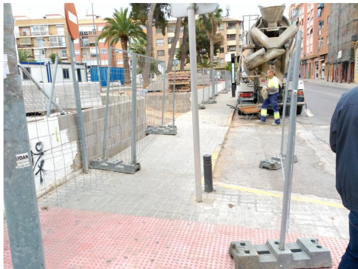
Imagen 2.44 Obras en la calle Camí Reial
