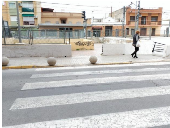
Imagen 2.19 Vado peatonal No accesible calle San Nicolás
