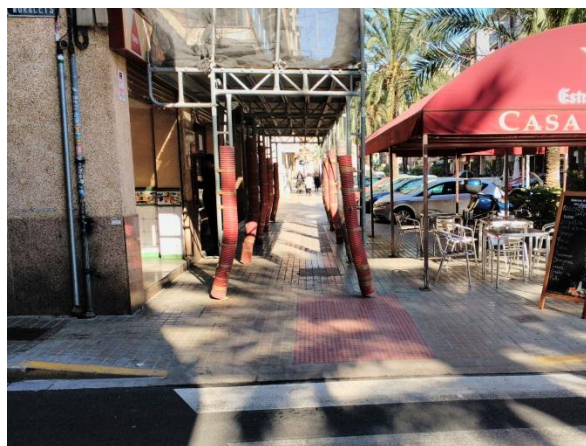
Imagen 2.45 Estructura auxiliar en calle Ramón y Cajal
