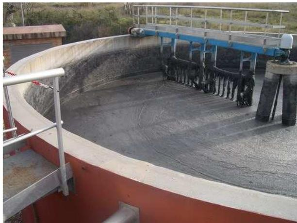
Figura 12. Espesador de fangos. (<https://cadcamcae.wordpress.com/tag/espesador-de-fangos/>)
