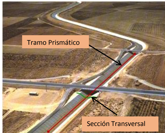
Figura I.1: Tramo de canal prismático [3].
