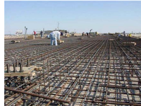
Montaje de las armaduras
