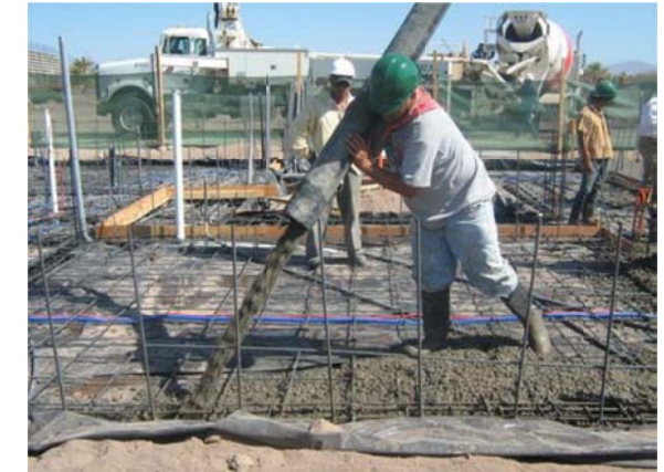
Homigonado con bomba
