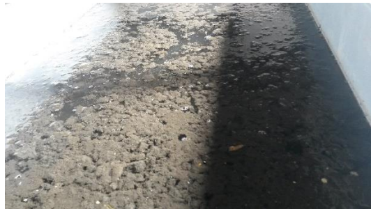
Figura N° 36: Fangos flotantes en el decantador lamelar.
