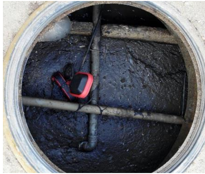
Figura N° 32: Flotación de fangos en el sedimentador.
