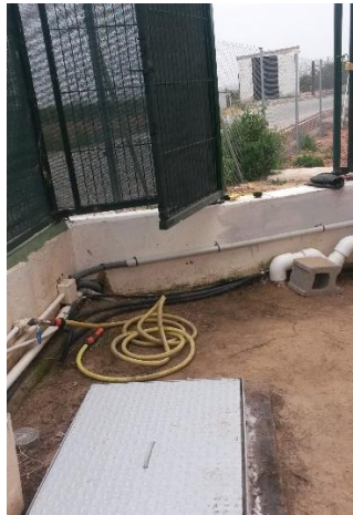
Figura N° 28: Construcción de acceso entre la cámara de rejas y el reactor biológico.
