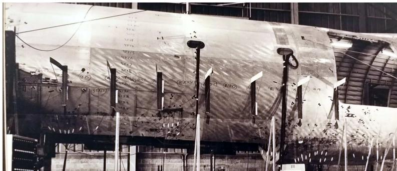
Figura 6.1: Ensayo de postpandeo de tensión diagonal en fuselaje semimonocasco, cfr. [47].
