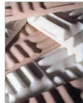
**5. Paneles de madera**. Contrachapado de okume chapado en arce, e=22mm. Sistema de grandes paneles suspendidos que permiten la colocación de luminarias y rejillas en grandes sales polivalentes.
