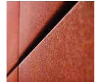
Hormigón visto con encofrado de madera. La construcción con hormigón depende de un buen encofrado y del cuidado en el proceso, para que el acabado final de su superficie resulte de calidad y visualmente acorde con las necesidades del proyecto. El hormigón, como envolvente expresiva, es en varios puntos del proyecto cerramiento y a la vez estructura, por tanto en la ejecución deberemos tener muy en cuenta la resolución de esta fachada pesada.
