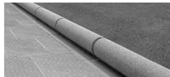
Para la separación entre pavimento rodado y pavimento peatonal se ha escogido el cilindro prefabricado de ESCOFET.
