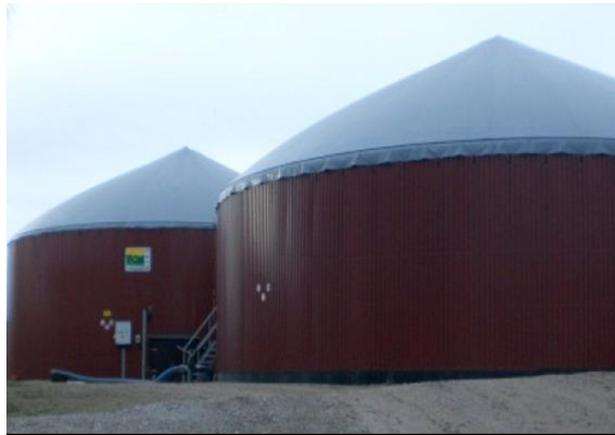
Figura 4. Digestores anaerobios primario y secundario.
