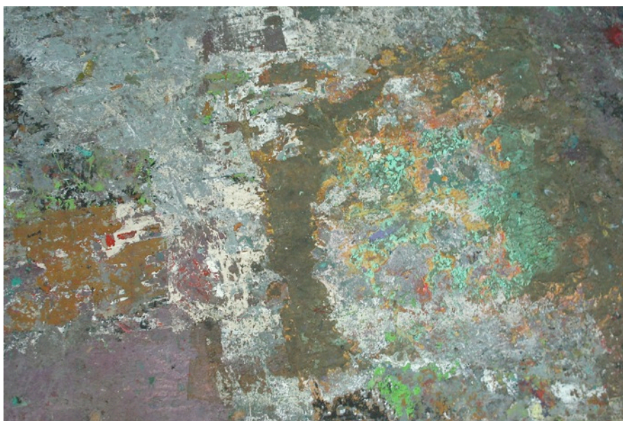
Figura 174- Fernando Paes. Detalle del piso del salón . 2015
