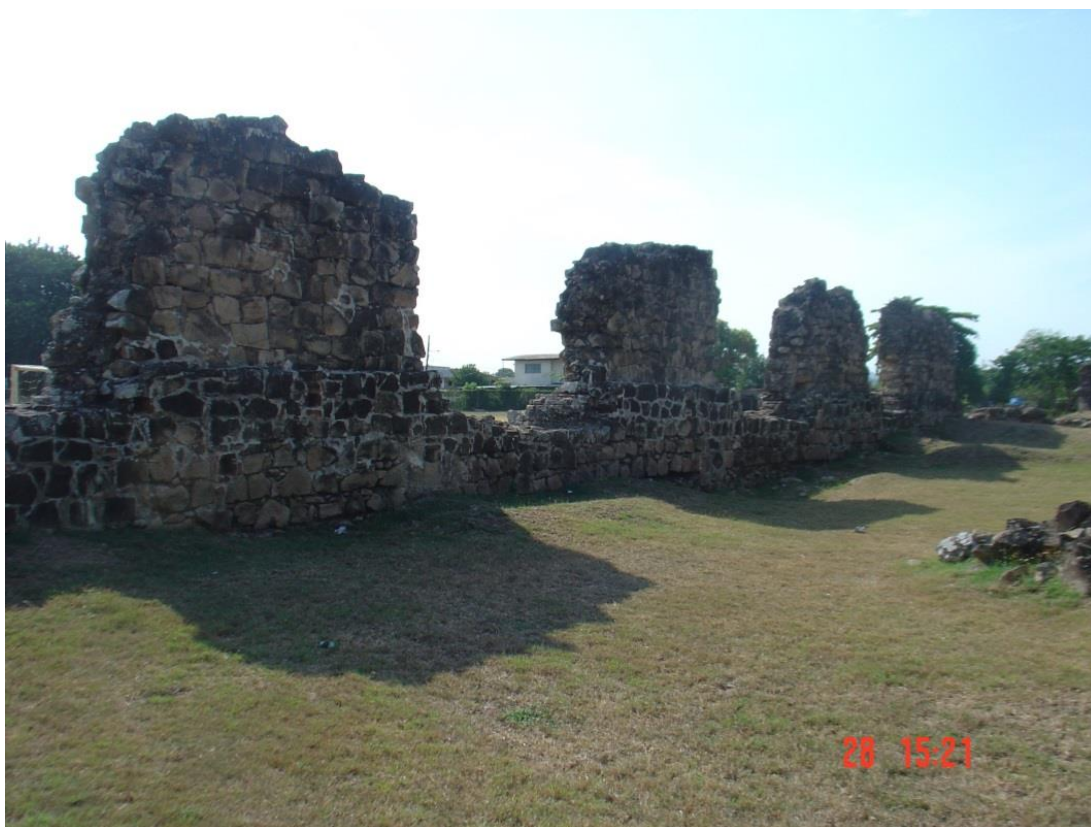
Imagen 2.55: consolidaciones en muros del hospital San Juan de Dios, aprox. 1997 (PPV).
