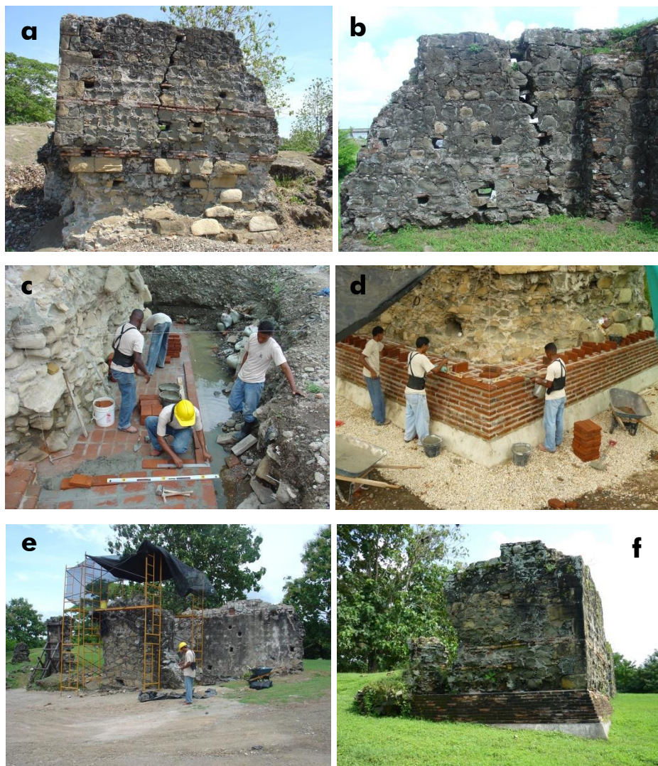
Imagen 3.27: trabajos del proyecto de consolidación 2005-2007. Ver anexo 2. A y b: antes de la intervención; c. y d. construcción del contrafuerte; e. y f. vistas finales de la consolidación.
