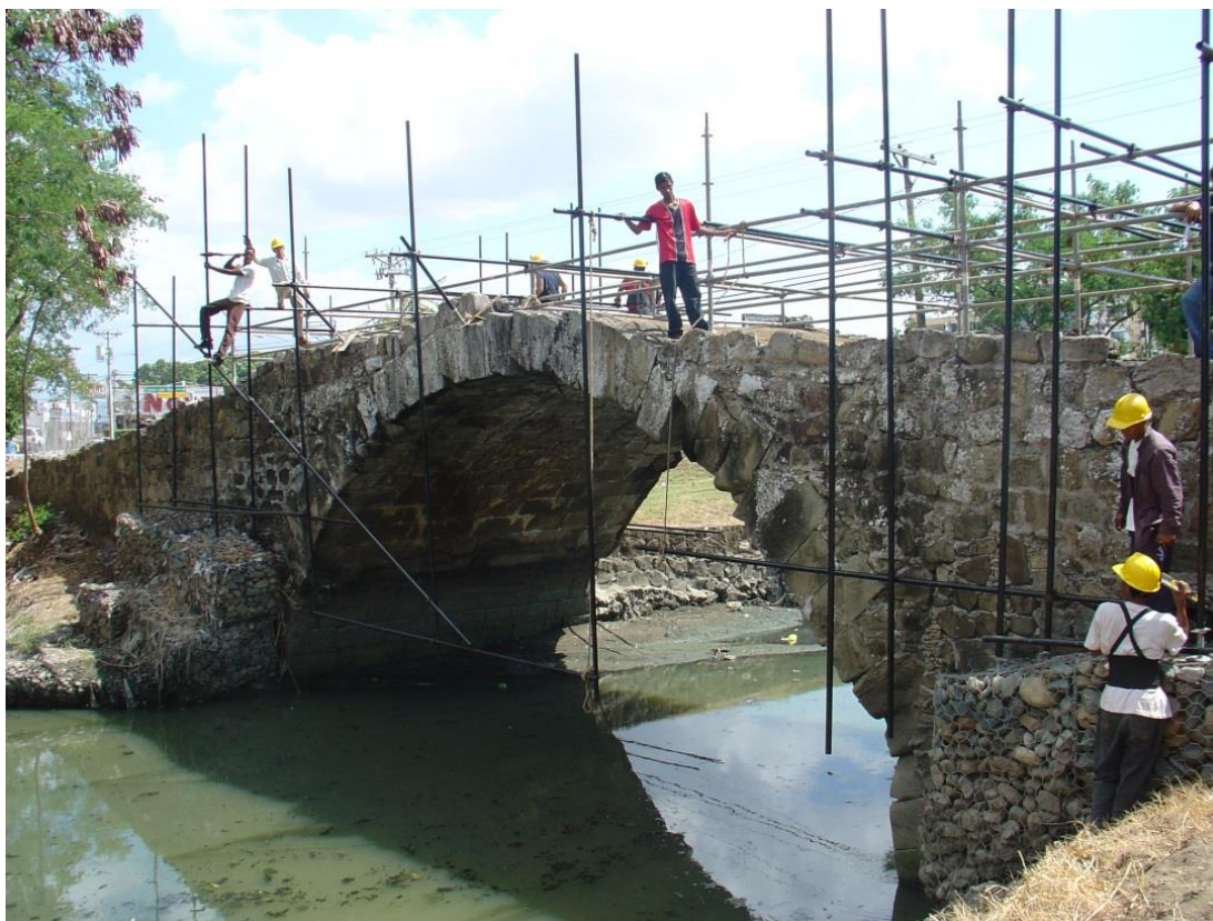
Imagen 2.62: colocación de andamios para realizar los trabajos de consolidación en el puente del Rey, 2005-2007 (PPV).
