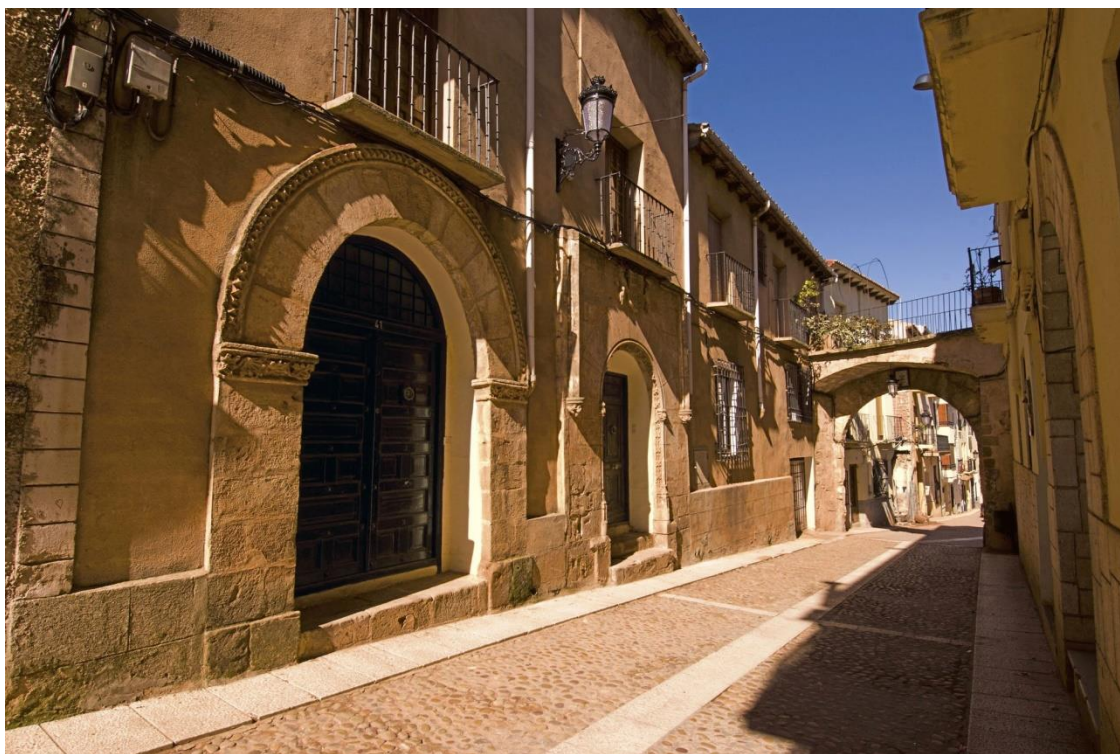
Imagen 4.41: viviendas de Alcaraz, en la Mancha (National Geographic).
