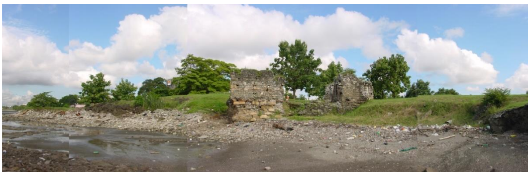
Imagen 3.25: las Casas Reales vistas desde el mar, aprox. 2001 (PPV).
