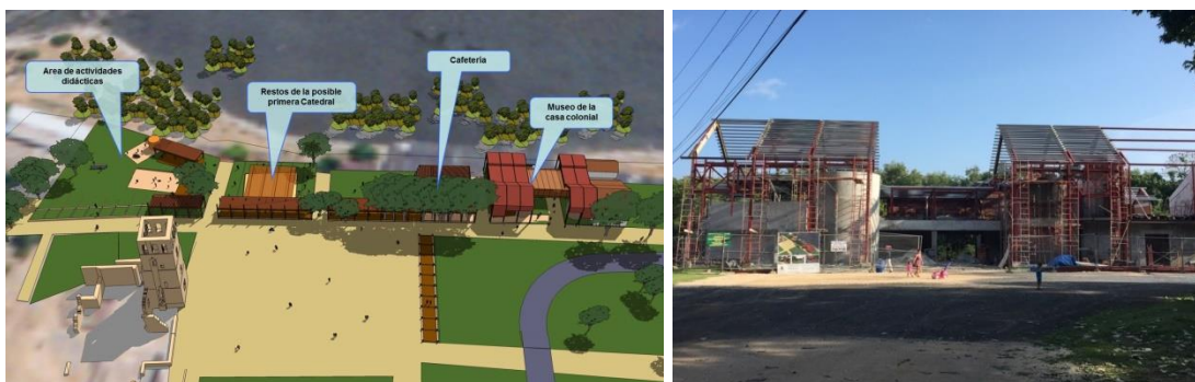
Imagen 2.64: a, perspectiva del proyecto de la plaza Mayor; b, y vista actual del proceso de construcción (PPV).
