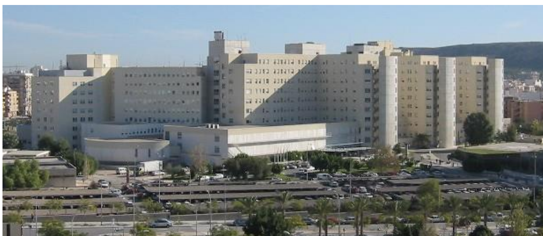
Figura 23. Vista del Hospital General Universitario de Alicante.
