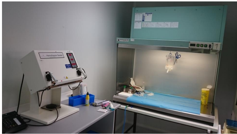
Figura 38. Sala limpia del CTA.
