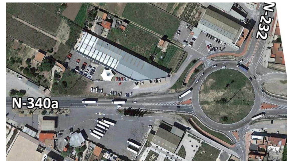
Figura 3. Ejemplo de glorieta convencional en intersección principal. Glorieta G5. (Situación previa y posterior a la actuación)
