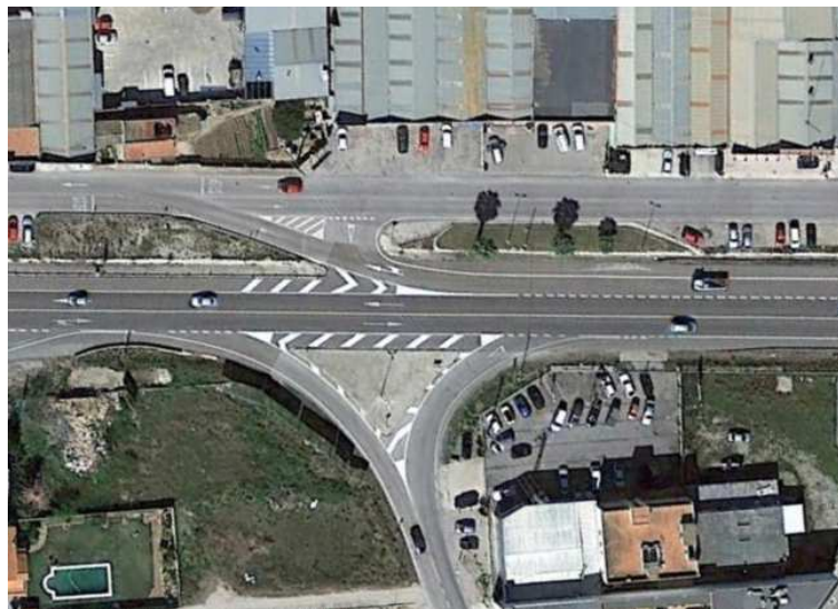
Figura 4. Ejemplo de solución adoptada en intersección secundaria. Intersección con Avenida Barcelona. (Situación previa y posterior a la actuación)
