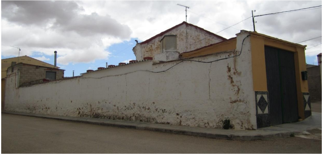
28 Fachada Norte. Fuente: Sara Monteagudo
