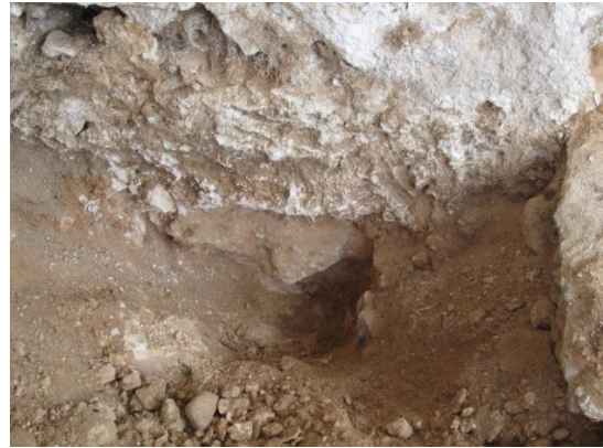
18 Cata de cimientos. Fuente: Sara Monteagudo
