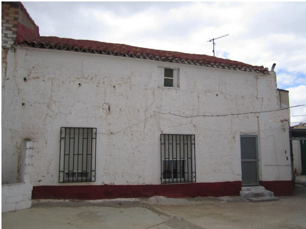
31 Fachada Noreste. Fuente: Sara Monteagudo
