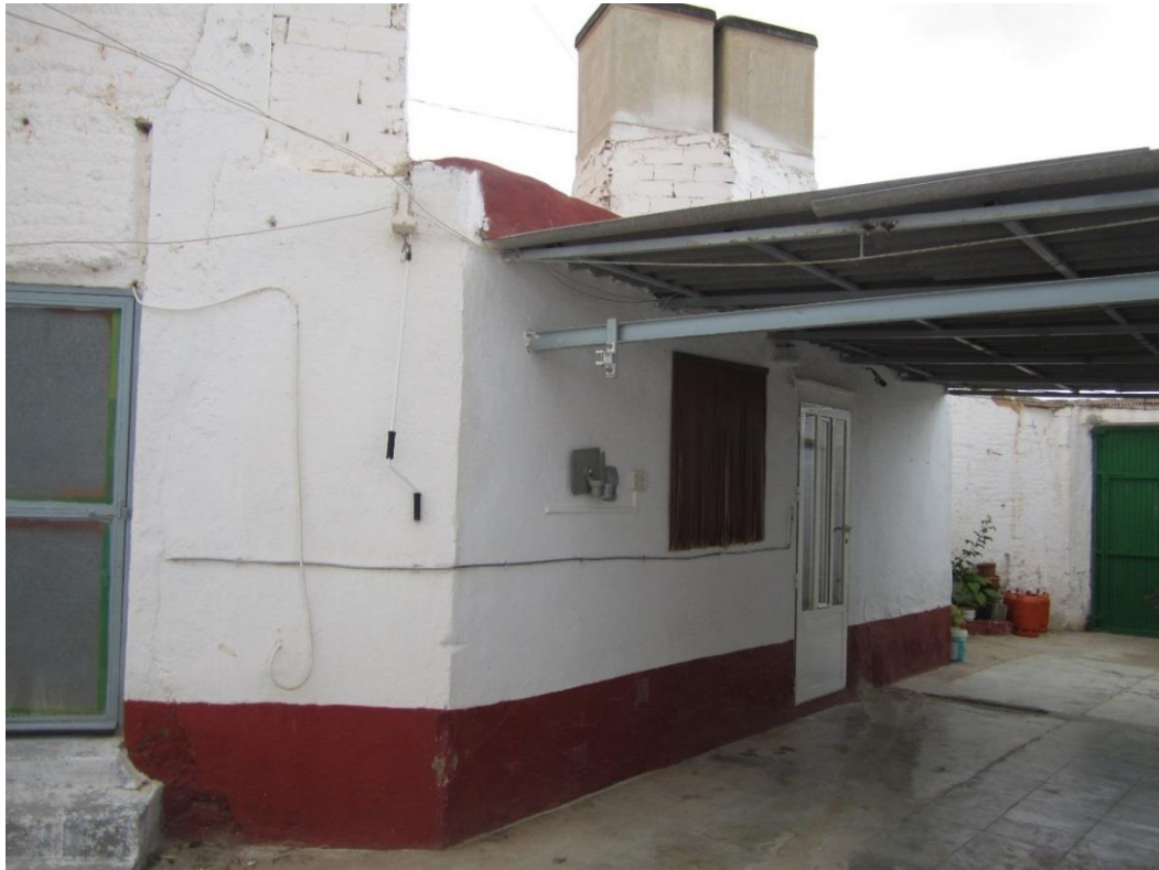
30 Fachada Norte. Fuente: Sara Monteagudo
