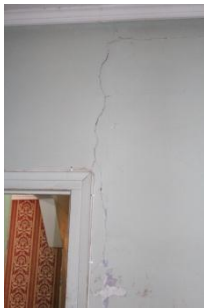
Figura60, 61, 62 y 63. Fisuras en paramentos verticales. 2016. Propia.
