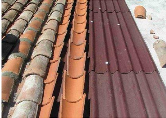
Figura74. Sistema de impermeabilización Onduline bajo teja. 2016. http://es.onduline.com/productos/impermeabilizacion-rehabilitacion-tejado-cubierta-ligera-bajo-teja-onduline .
