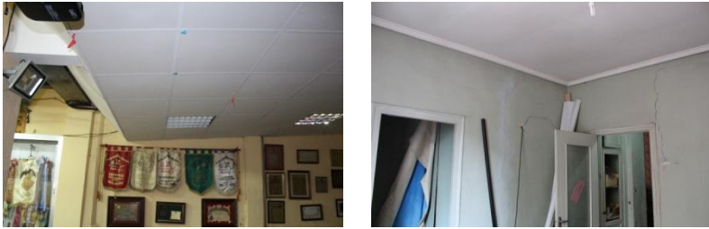
Figura 47 y 48. Falso techo planta baja y planta primera. 2016. Propia.
