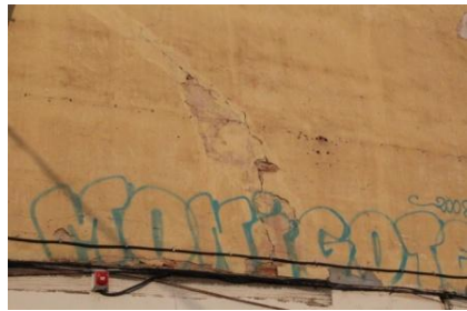
Figura60, 61, 62 y 63. Fisuras en paramentos verticales. 2016. Propia.
