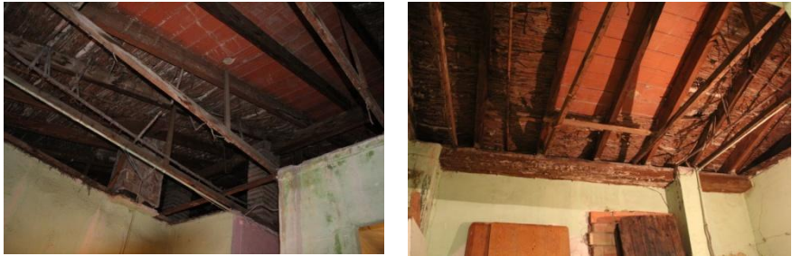
Figura64 y 65. Interior cubierta. 2016. Propia.
