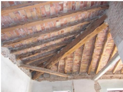
*Figura 32. Cubierta inclinada de viguetas de madera y tablero cerámico. 2014. SANZ GUERRERO, V.*
