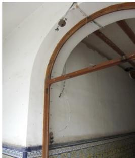
*Figura 43. Mecanismos de madera para la instalación eléctrica. 2014. SANZ GUERRERO, V.*
