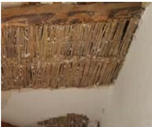
*Figura 54. Imagen de la cara superior e inferior del falso techo de cañizo.
