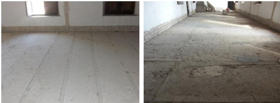
Figura 31 Forjado unidireccional de viguetas de madera (izquierda) y con viguetas de material cerámico (derecha). 2014. SANZ GUERRERO, V.
