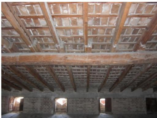
*Figura 33. Cubierta inclinada de viguetas de madera y tablero cerámico sobre cabirones de madera. 2014. SANZ GUERRERO, V.*
