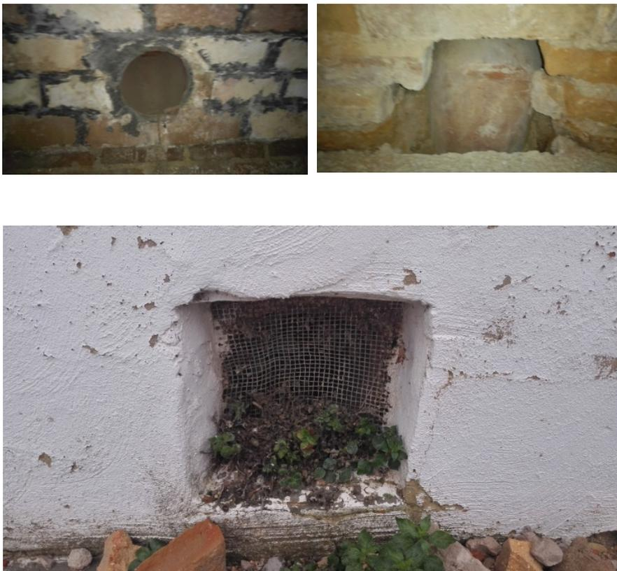
*Figura 46. Imágenes de la ventilación en el sótano. Arriba, imagen desde el interior del sótano. Imagen intermedia, elemento cerámico de conexión interior-externo. Imagen de abajo, rejilla de conexión con el exterior. 2016. SANZ GUERRERO, V.*
