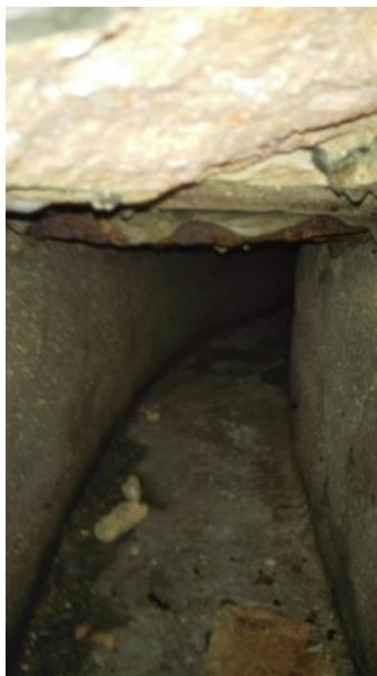
*Figura 44. Excavación para mostrar el sistema de saneamiento e interior de dicha instalación. Se aprecia el refuerzo de gravas junto a la conducción. 2016. SANZ GUERRERO, V.*
