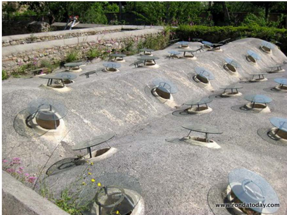
Figura 7.2. Solución de ventilación utilizada en la intervención de los baños árabes de Ronda. 2016. Ronda today.
