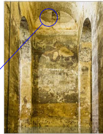
Figura 2. Frente sur nave 3
