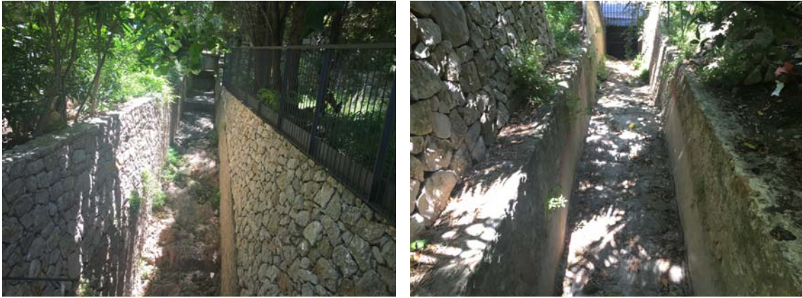
Figura 3. Canal de recogida de aguas en su salida de Montsant, a la izquierda se aprecia en el canal el terreno natural de roca. 2016. Autor
