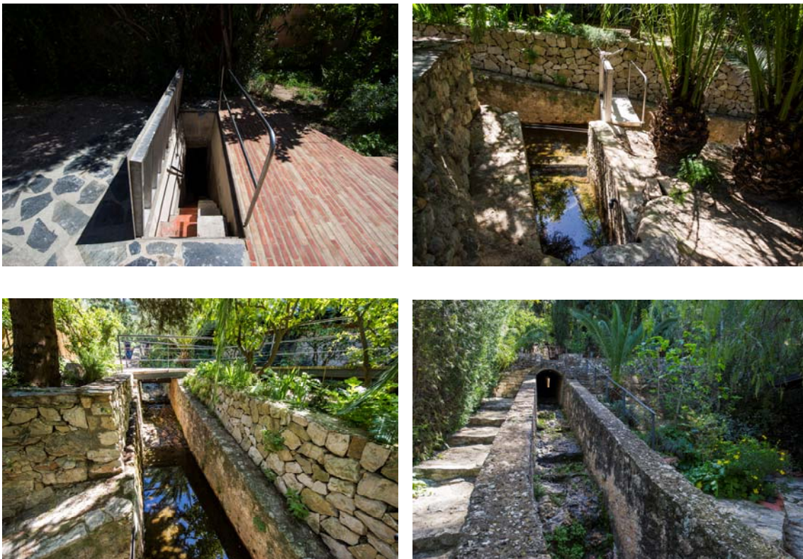
Figura 11. Acceso al aljibe y canal de recogida de aguas desde la Costa del Castell.2016. Edu Francés
