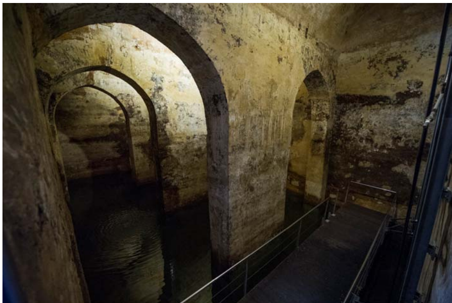
Figura 1. Vista aljibe desde escalera de acceso. 2016. Edu Francés
