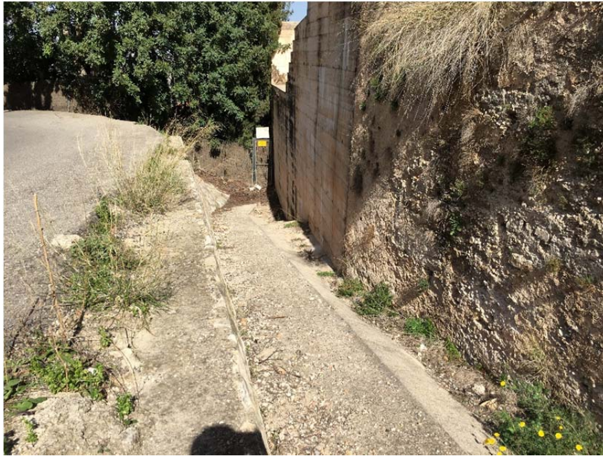
Figura 4.8. Canal de recogida de aguas accediendo a la parcela de Montsant.2016. Autor.
