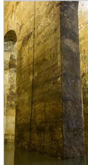
Figura 2. Muro intermedio nave 3 vista este
