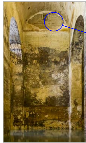
Figura 1. Frente sur nave 2
