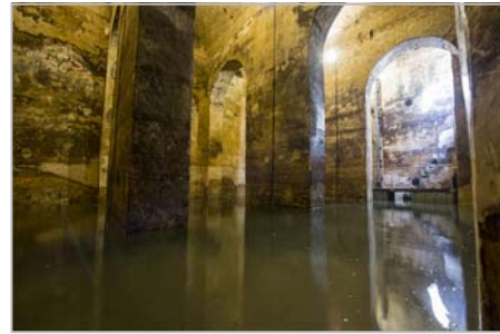
Figura 1. Muro intermedio nave 3 vista este
