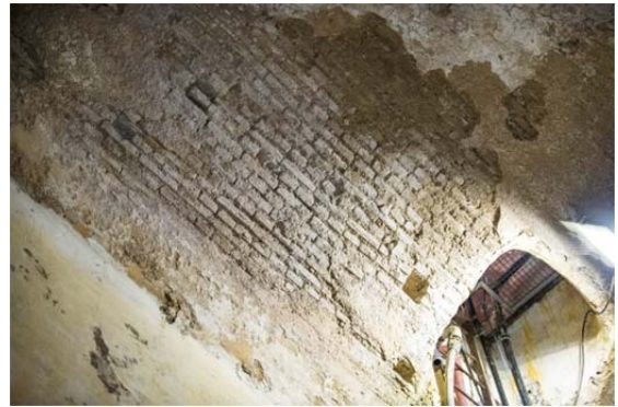
Figura 6.2. Pérdida del material de revestimiento en bóveda. 2016. Edu Francés
