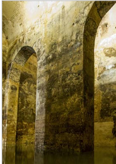
Figura 1. Muro intermedio nave 3 vista oeste
