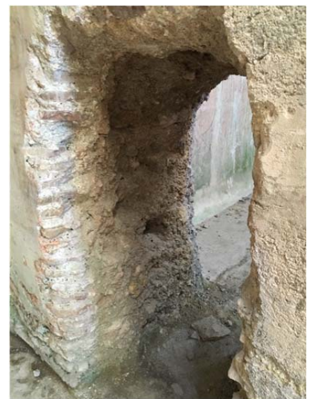
Figura 4.11. Izquierda, arcos intermedios ligeramente apuntados. Derecha, recrecido posterior de ladrillo macizo y muro de tapia de cal. 2016. Autor
