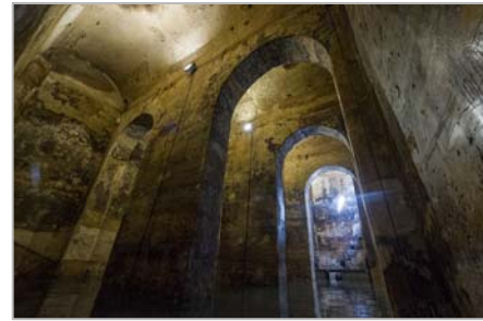
Figura 2. Muro intermedio nave 4 vista este
