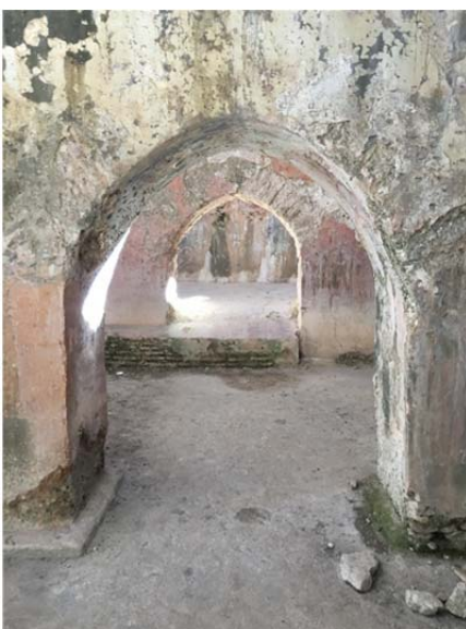
Figura 4.11. Izquierda, arcos intermedios ligeramente apuntados. Derecha, recrecido posterior de ladrillo macizo y muro de tapia de cal. 2016. Autor
