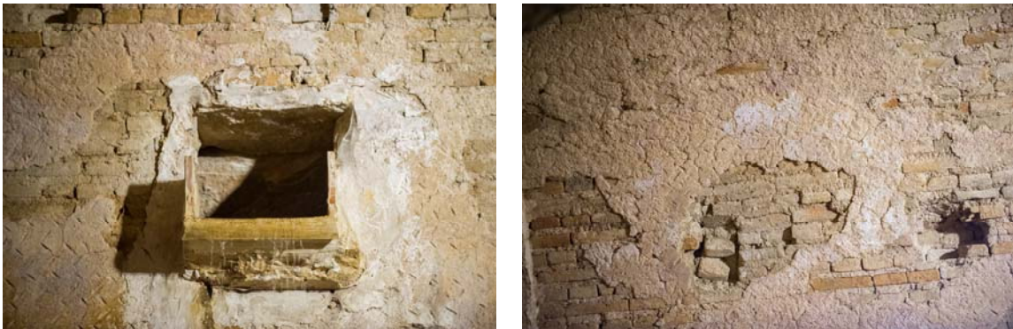
Figura 6. Izquierda, detalle orificio abastecimiento de agua. Derecha, detalle lesión en bóveda. 2016. Edu Francés
