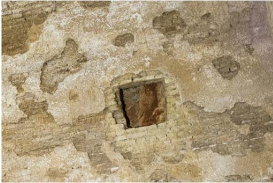
Figura 6.2. Pérdida del material de revestimiento en bóveda. 2016. Edu Francés
