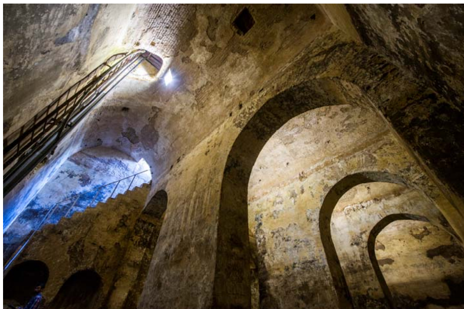
Figura 2. Bóveda nave 1 y escalera de acceso al aljibe. 2016. Edu Francés
