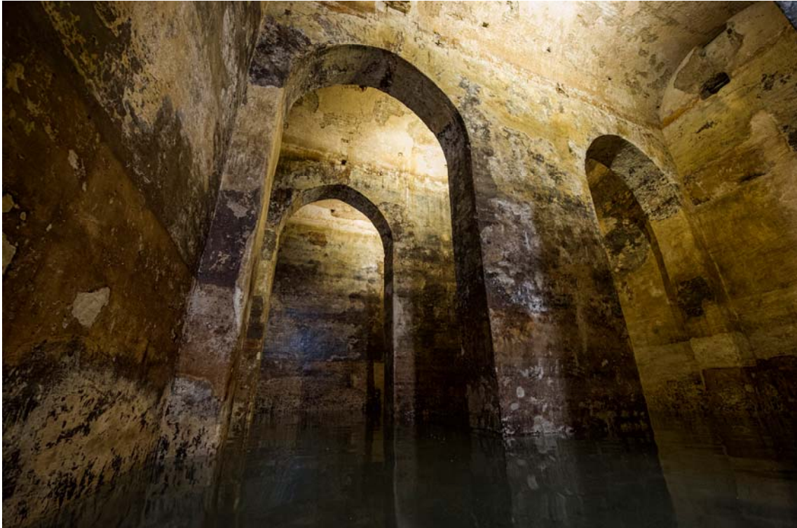
Figura 3. Vista arquerías intermedias de nave 2. 2016. Edu Francés
