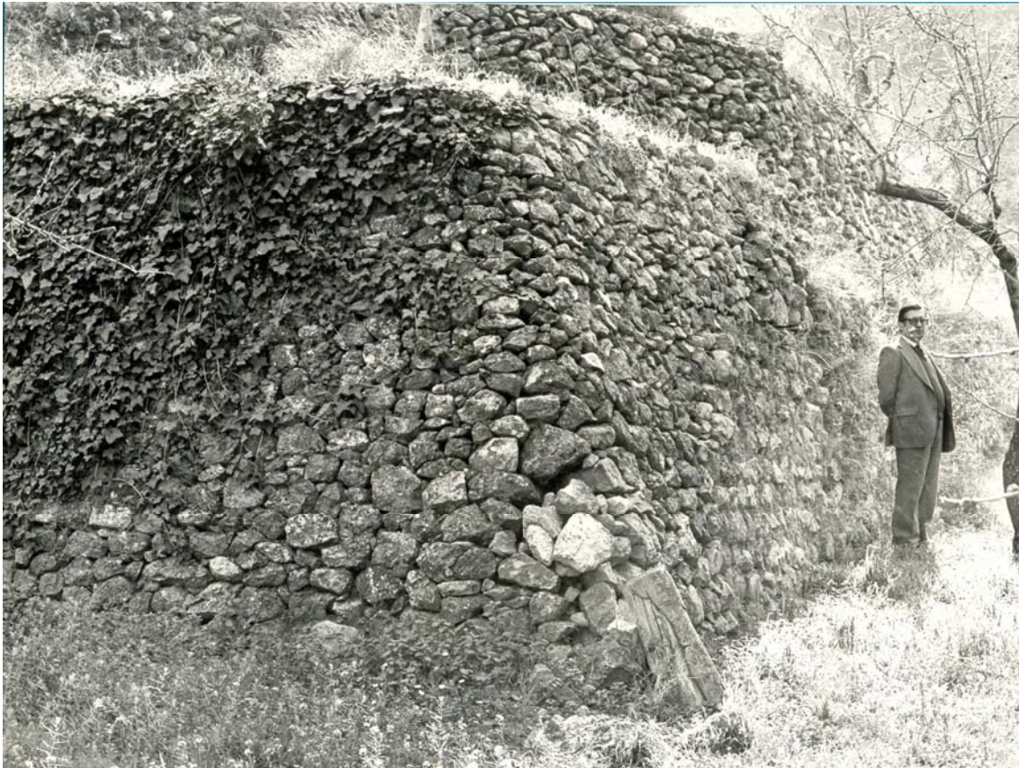
Figura 1. Muro de mampuestos en exterior aljibe, posiblemente, mitad del siglo XX. Se desconoce fecha y autor.
