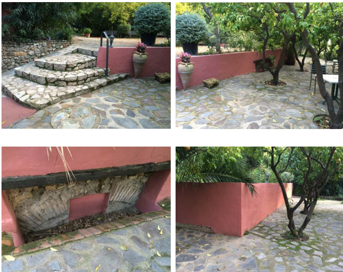
Figura 2. Escaleras de acceso al jardín superior al aljibe. Murete perimetral y vista de parte de la bóveda y aliviadero de la nave 3. 2016. Autor
