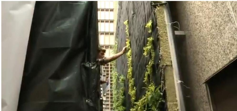
Imagen 37. Fotos del proceso de montaje, en la imagen se observa cómo se realizan las rasgaduras manualmente para alojar las plantas.
