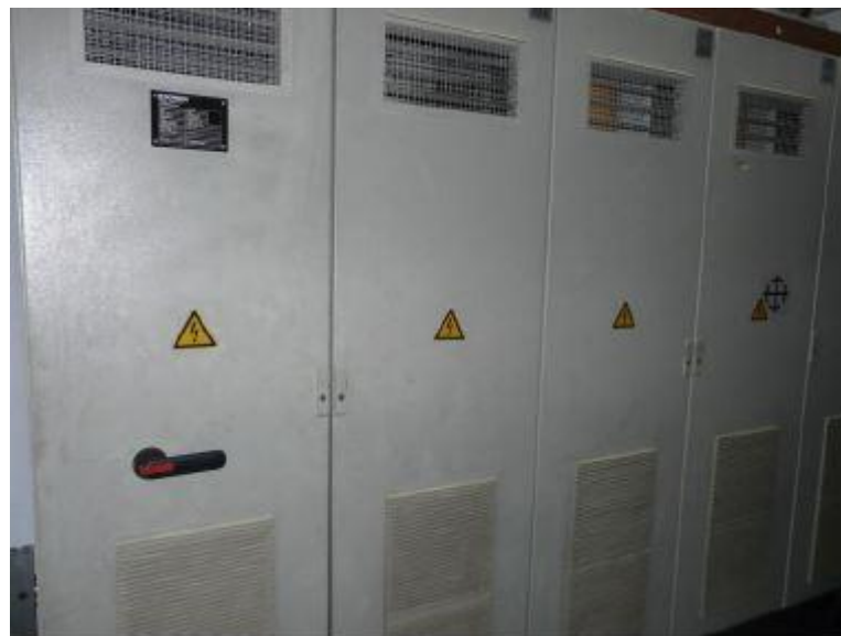
Figura 3.8 Armarios de control del freno
