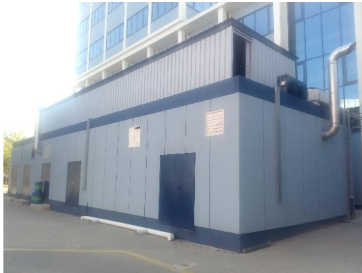
Figura 3.1 Sala de ensayos nº 12. Vista exterior
